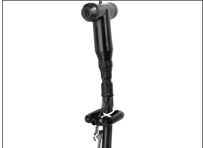
Figura 56. Sensores de corriente colocados alrededor del neutro concéntrico aterrizado del cable.
