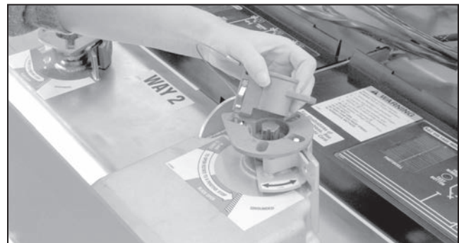
Figura 77. Inserte la llave de bloqueo mecánico.
