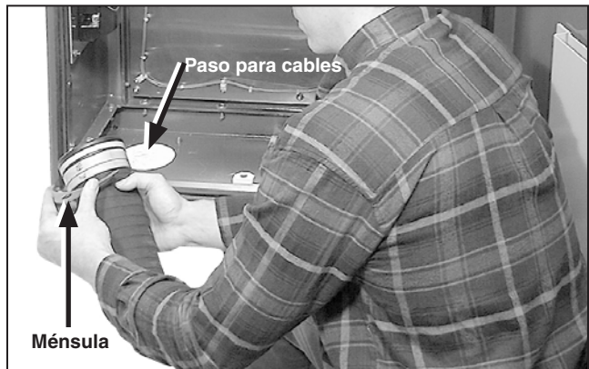
Figura 88. Coloque las ménsulas de soporte en el canal ranurado del conducto.
