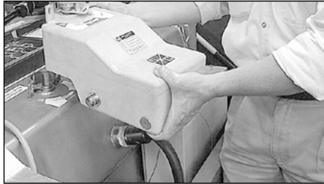
Figura 64. Colocación del moto operador por encima del eje de operación en el equipo.
