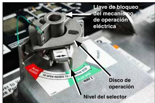
Figura 36. Indicación de CERRADO en el tablero de control del motor correspondiendo a la posición del moto operador.
