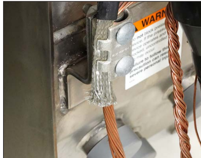
Figura 112. Conecte el cable con capa protectora a la tierra del tanque.
