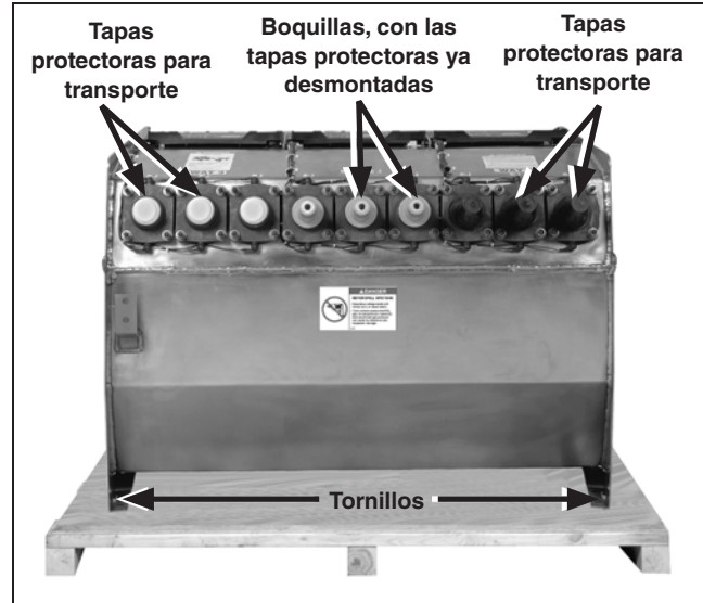
Figura 78. El interruptor va atornillado a la tarima en cuatro puntos para el embarque. (Unidad manual mostrada con fines ilustrativos).
