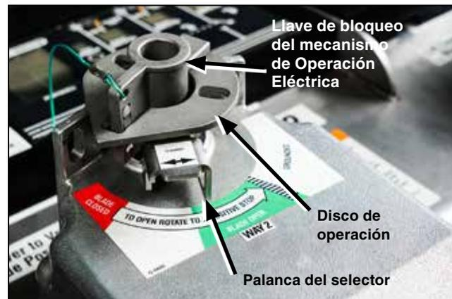
Figura 100. Indicación de la posición "Cerrado" en el moto operador.
