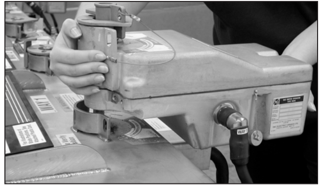
Figura 96. Coloque el moto-operador sobre el eje de operación del equipo.
