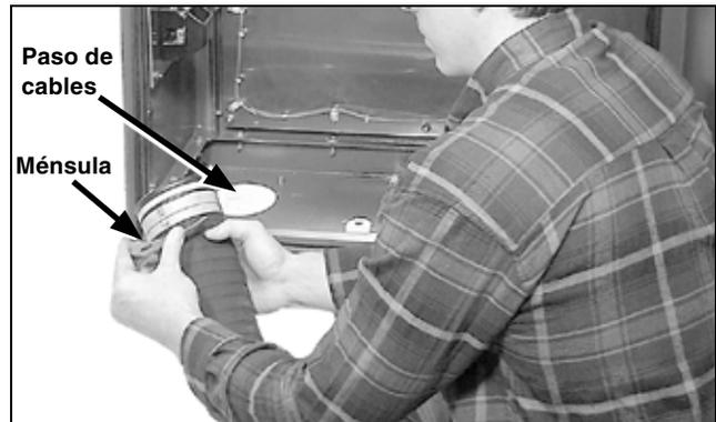
Figura 87. Colocación de las ménsulas de soporte en el canal del conducto.
