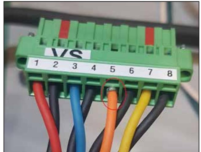
Figura 26. Ejemplo de una conexión impropia que queda retrocedida.
