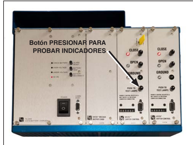
Figura 133. El botón PUSH TO TEST LAMPS (PULSAR PARA PROBAR LAS LÁMPARAS).
