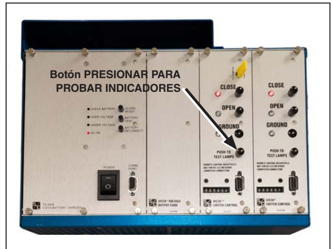
Figura 43. El botón PUSH TO TEST LAMPS (PRESIONAR PARA PROBAR INDICADORES) en el tablero de control.
