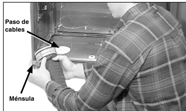
Figura 119. Colocación de las ménsulas de soporte en el canal del conducto.
