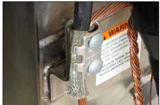
Figura 113. Conexión del cable blindado a la tierra del tanque.
