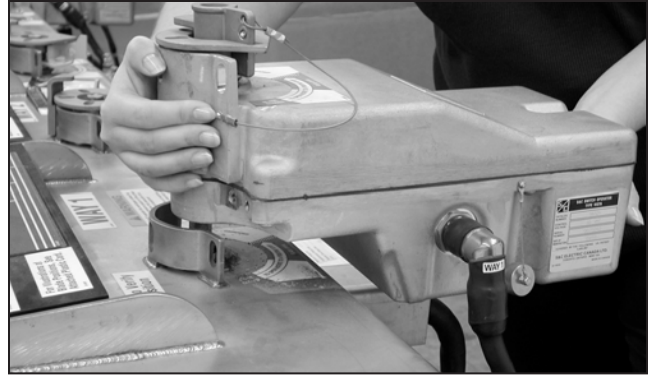
Figura 126. Coloque el moto-operador sobre el eje de operación del equipo.
