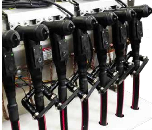
Figura 114. El cableado ya está sujeto al sensor de corriente.
