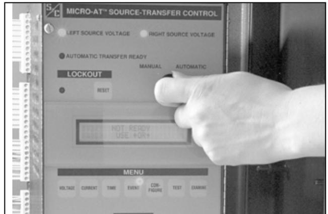
Figura 38. Interruptor de **MANUAL/AUTOMÁTICO** en el Control Micro-AT® de Transferencia de Fuente.
