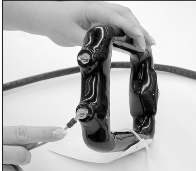
Figura 20. Conecte los sensores de corriente al cableado requerido.
