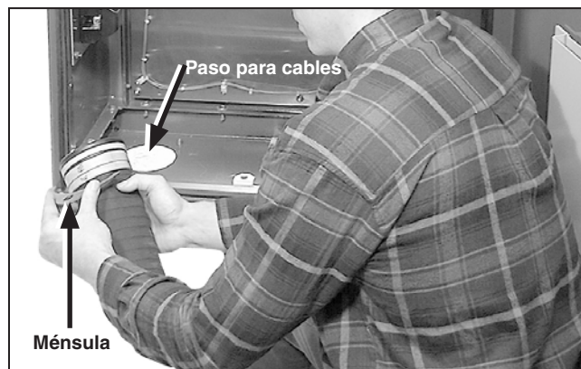
Figura 60. Coloque las ménsulas de soporte en el canal ranurado del conducto.
