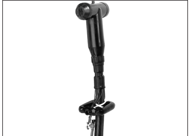
Figura 21. Sensores de corriente colocados alrededor del neutro concéntrico aterrizado del cable.
