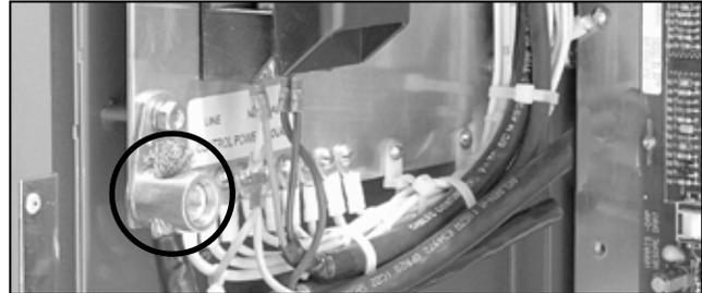
Figura 94. Lengüeta de cobre y bloque de fusibles.
