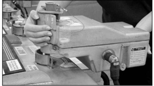
Figura 95. Colocación del moto operador por encima del eje de operación en el equipo.
