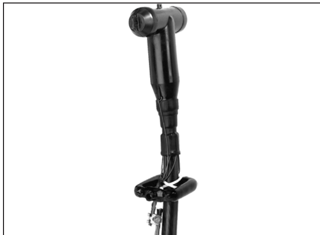
Figura 84. Sensores de corriente colocados alrededor del neutro concéntrico aterrizado del cable.●
