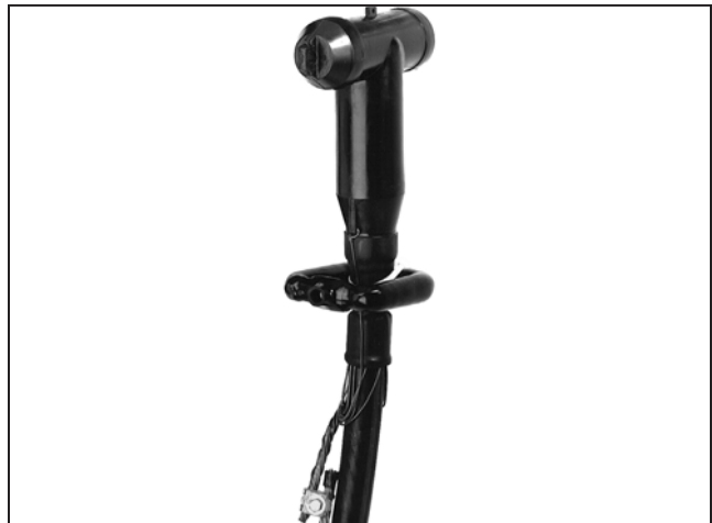
Figura 115. Sensores de corriente colocados por encima del neutro concéntrico aterrizado del cable.●
