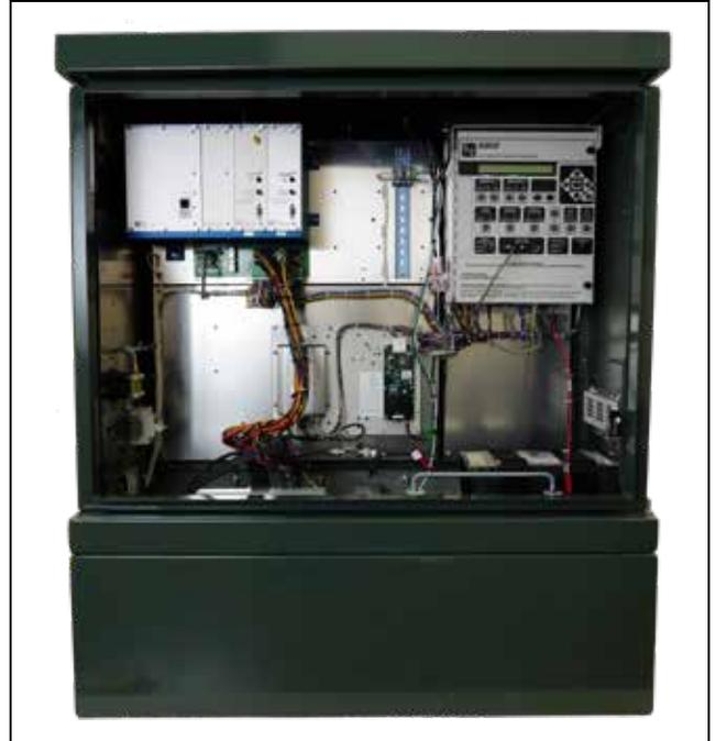
**Figura 74.** Se muestra el gabinete de bajo voltaje estilo bóveda con un control de interruptor automático 6802 y provisión para comunicaciones.
