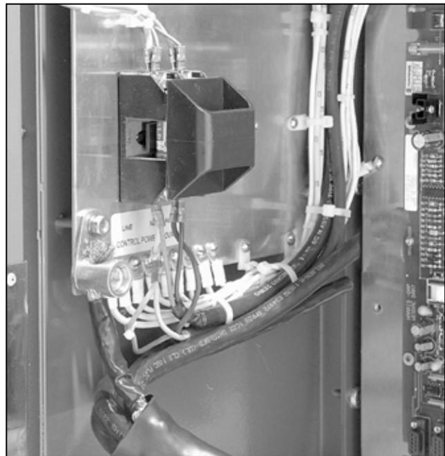
Figura 29. Bloque de fusibles.
