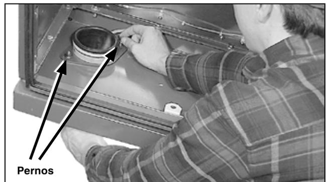
Figura 57. Colocación y aseguramiento del ensamble a través del paso de cables.
