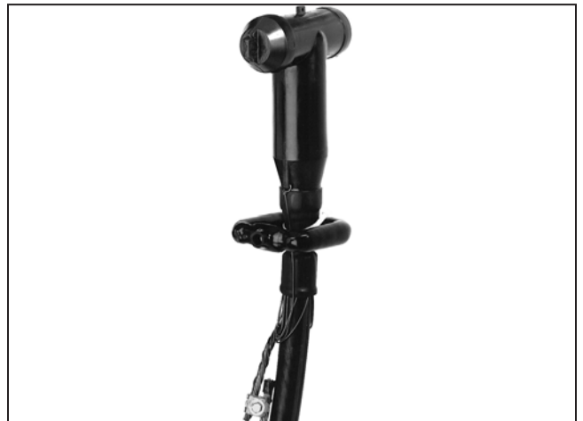
Figura 22. Sensores de corriente colocados por encima del neutro concéntrico aterrizado del cable.
