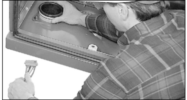
**Figura 121. Canalice los cables a través del paso de cables.**
