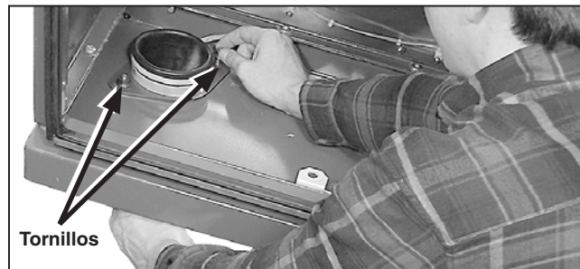
Figura 61. Coloque el conjunto en el paso para cables y asegúrelo.
