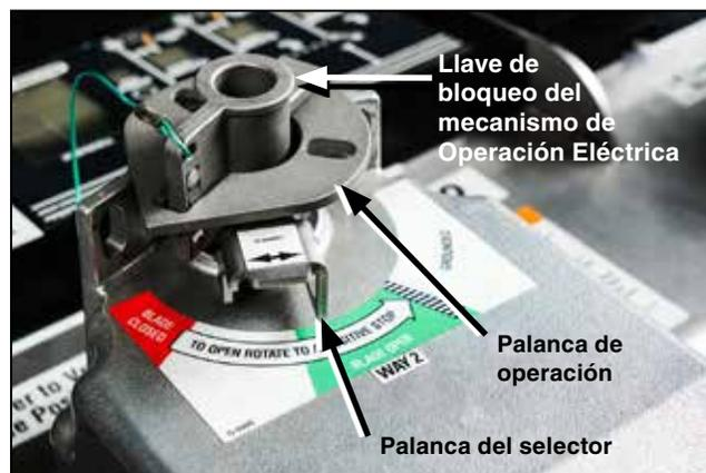
Figura 133. Indicación de la posición Cerrado en el moto operador
