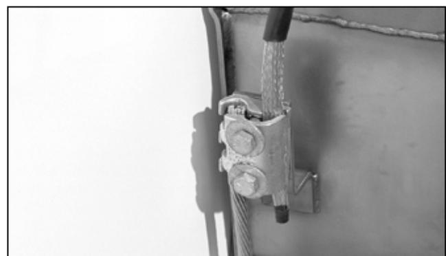
Figura 81. Conexión de cable con capa protectora a la tierra del tanque.
