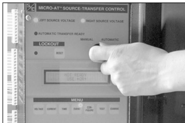
Figura 135. El interruptor MANUAL/AUTOMÁTICO en el Control de Transferencia de Fuente Micro-AT.
