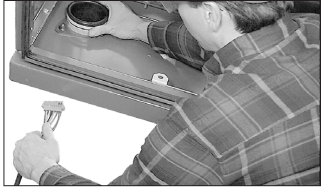
Figura 90. Inserción de los cables en el gabinete de baja tensión a través de los tubos y conductos.
