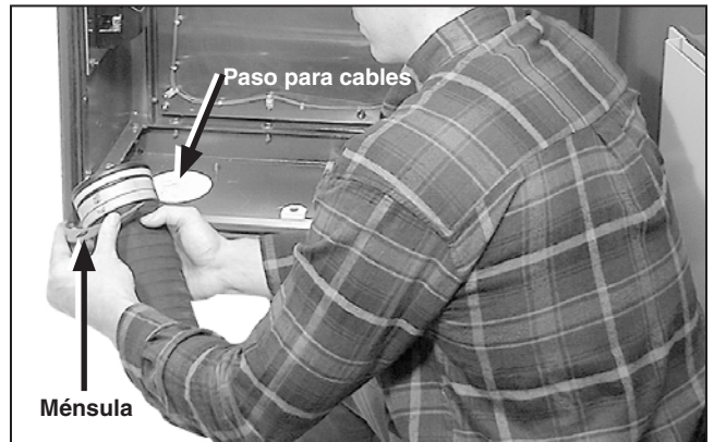
Figura 118. Coloque las ménsulas de soporte en el canal del conducto.
