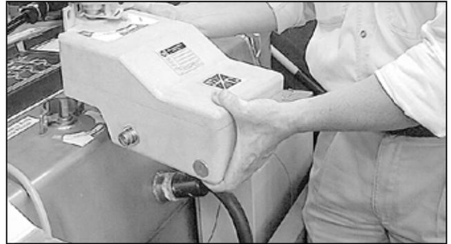
Figura 30. Colocación del moto operador sobre el eje de operación del equipo.
