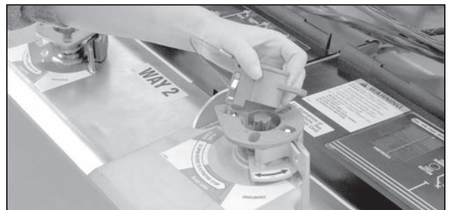
Figura 99. Inserte la llave de bloqueo mecánico.
