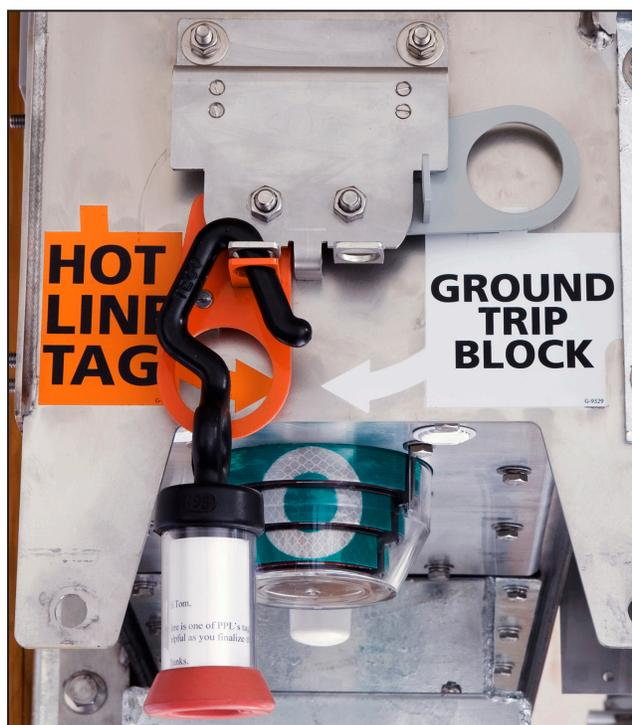
Figura 29. Etiqueta de linha viva aplicada manualmente e "etiquetada".
