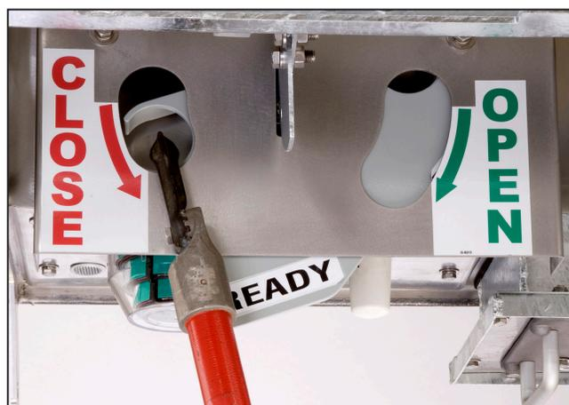
Figura 27. Fechamento dos interruptores com uma vara de manobra.
