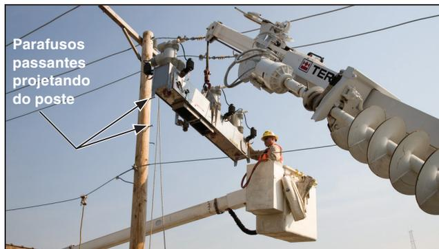
Figura 7. Instalação correta do interruptor de falta IntelliRupter.
