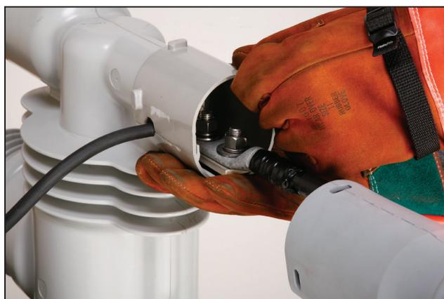
Figura 11. Instalação da cobertura superior do terminal.
