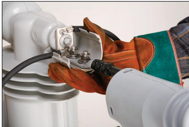
Figura 10. Instalação da cobertura inferior do terminal.
