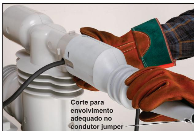
Figura 12. Instalação da cobertura de proteção de vida selvagem.
