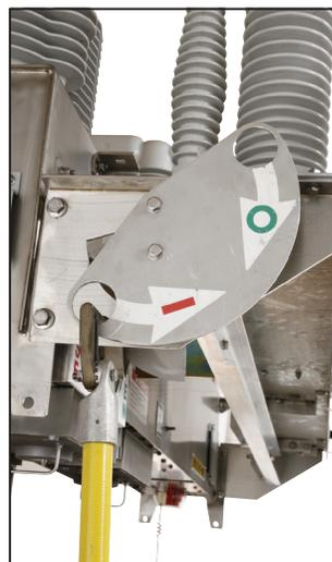
Figura 32. Fechamento da seccionadora pela alavanca de operação.
