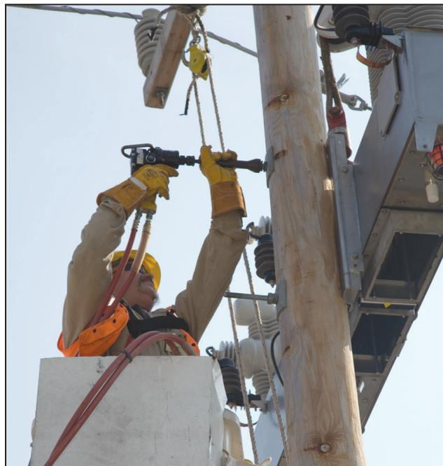
Figura 9. Aperto das porcas dos parafusos passantes. Assegure-se que foi instalada uma arruela lisa entre cada cabeça do parafuso e o suporte.
