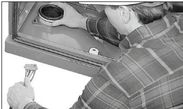
Figura 118. Inserción de los cables en el gabinete de baja tensión a través de los tubos y conductos.
