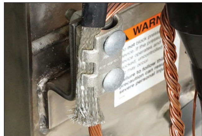
Figura 110. Conecte el cable con capa protectora a la tierra del tanque.
