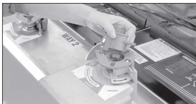
Figura 105. Quite la llave de bloqueo mecánico.
