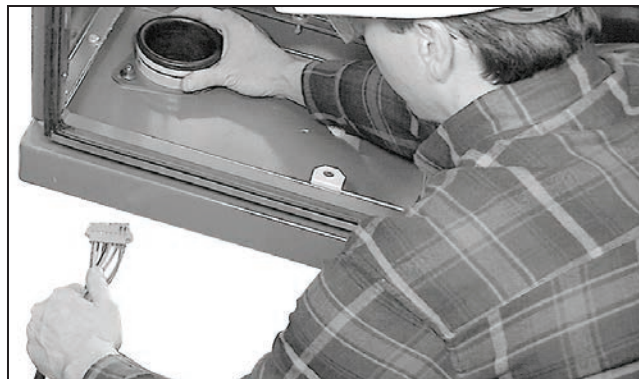
Figura 61. Inserción de los cables en el gabinete de baja tensión a través de los tubos y conductos.
