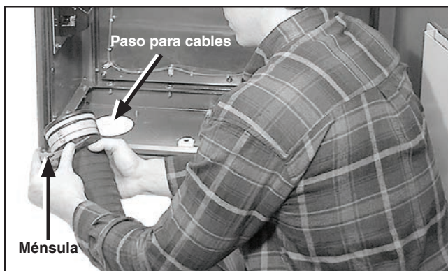
Figura 87. Coloque las ménsulas de soporte en el canal ranurado del conducto.
