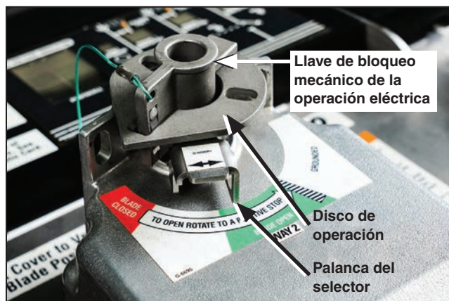
Figura 100. La indicación CLOSE (Cerrado) en el tablero de control del motor coincide con la posición del moto-operador.
