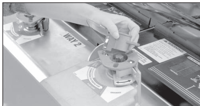
Figura 75. Inserte la llave de bloqueo mecánico.
