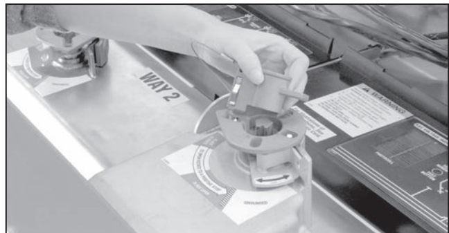
Figura 70. Inserte la llave de bloqueo mecánico.
