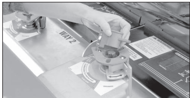
Figura 127. Inserte la llave de bloqueo mecánico.
