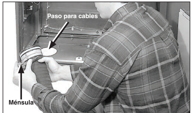
Figura 116. Coloque las ménsulas de soporte en el canal del conducto.
