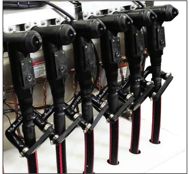
Figura 111. El cableado está sujeto a los sensores de corriente.
