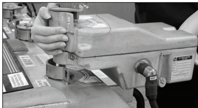
Figura 95. Coloque el moto-operador sobre el eje de operación del equipo.
