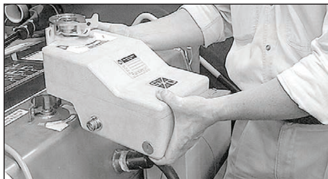
Figura 36. Coloque el moto-operador sobre el eje de operación del equipo.
