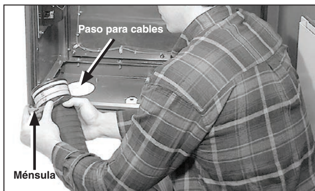
Figura 59. Coloque las ménsulas de soporte en el canal ranurado del conducto.
