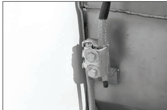
Figura 53. Conecte el cable blindado a la tierra del tanque.
