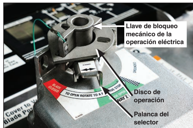
Figura 42. Indicación de la posición de CERRADO del moto-operador.
