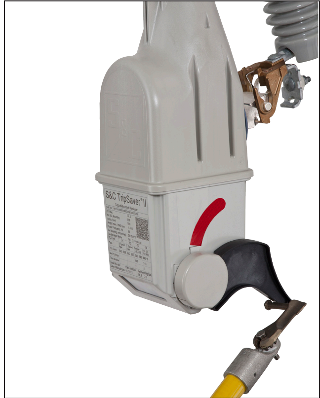
Figura 24. Coloque la pértiga bajo la palanca y empujela hacia arriba.
