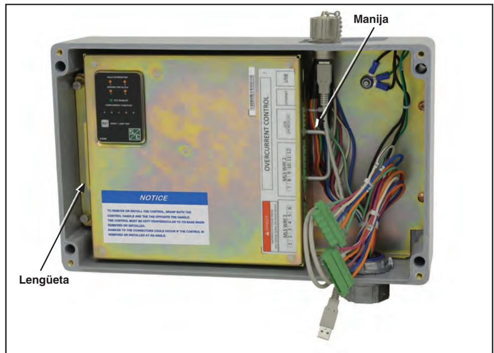
Figura 6. Tome tanto la manija como la lengüeta y levante el módulo para retirarlo de la base.
