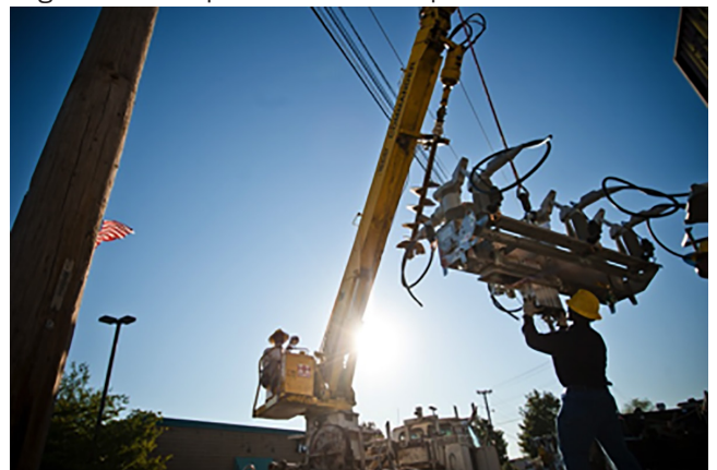
Instalación de un Interruptor de Fallas IntelliRupter.
