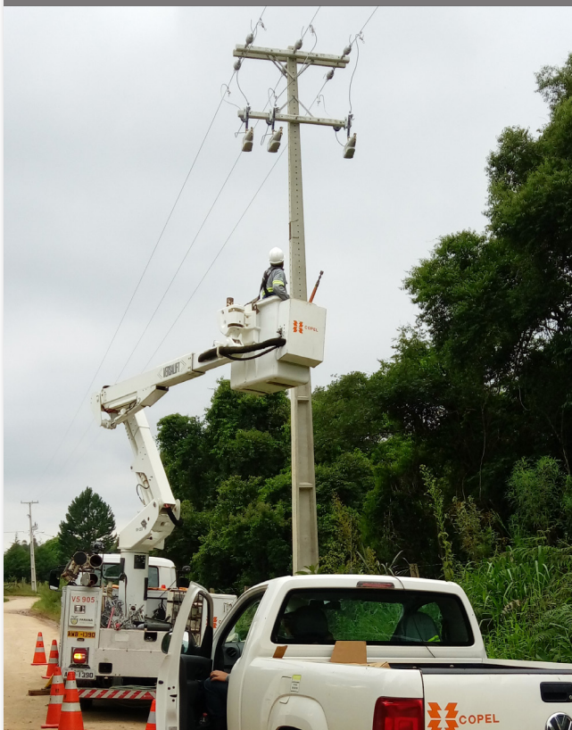
El equipo de COPEL instala reconectores TripSaver II.
