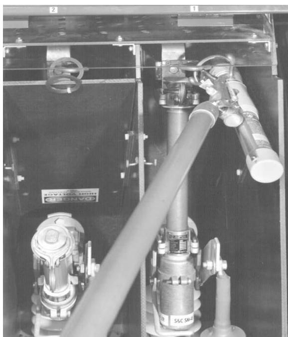
图 9 Loadbuster 上的挂钩与电力熔断器上的吊钩相连接
