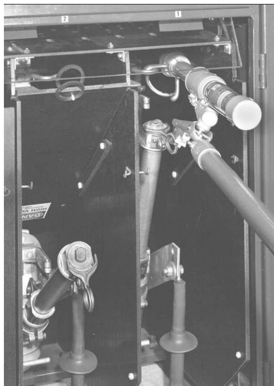
图 12 从电力熔断器上取下 Loadbuster
