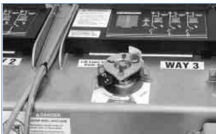
在操作选择器的最左边，允许在分闸和接地间操作。
