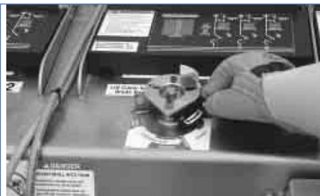
旋转操作指示器到最左边，开关可以接地
