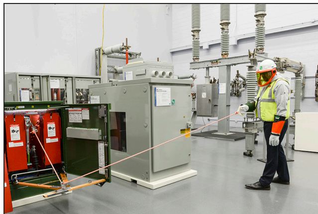
Figura 14. Retírese del equipo hasta que el cable esté tenso. Jale la palanca con un movimiento rápido y firme para operar el Interruptor Uni-Rupter.
