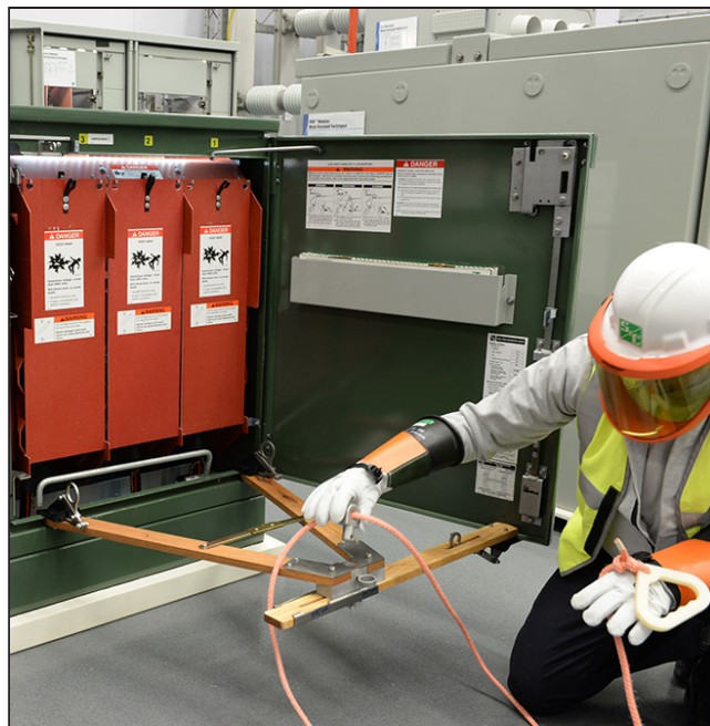
Figura 17. Jale el anillo de retención del cable para liberar el canal del cable. Remueva el canal del cable.
