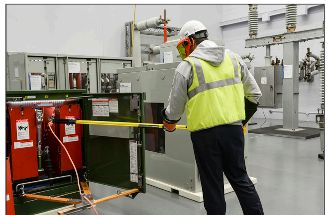
Figura 13. Inserte el gancho del fusible en el anillo de tiro del fusible y libere la pértiga estilo escopeta.
