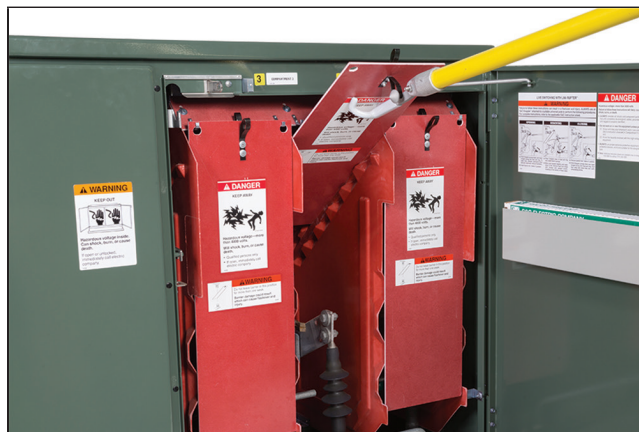
Figura 16. Insertando la barrera frontal de doble propósito en la posición de “deslizamiento” utilizando la Grappler.
