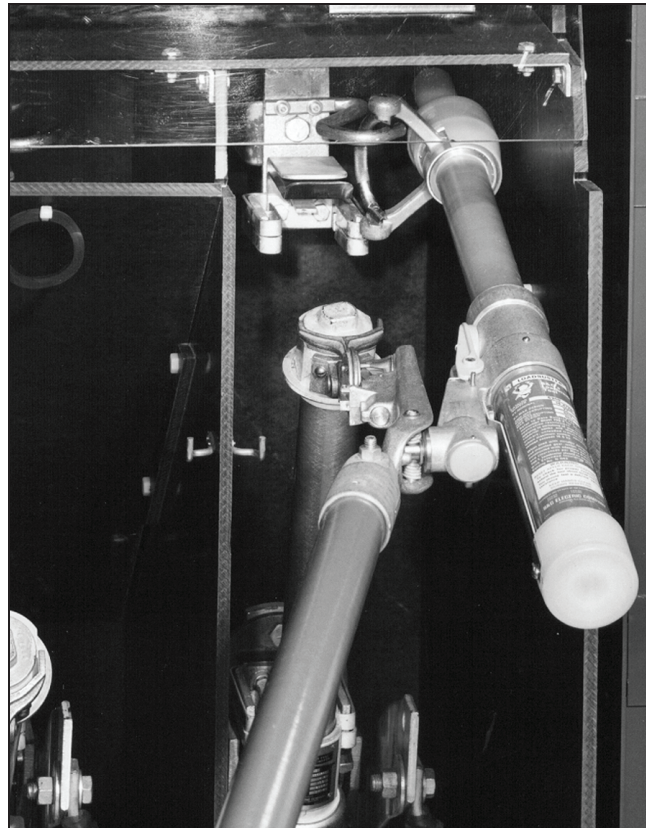
Figura 10. La herramienta Loadbuster en posición de Disparo.
