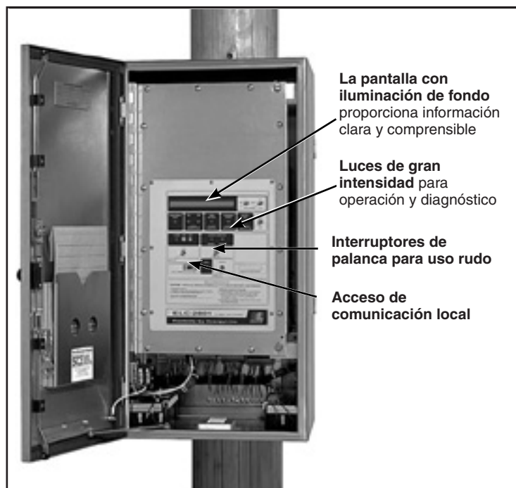
Figura 17. CCU especialmente diseñada que incluye UTR ELC-2801.
