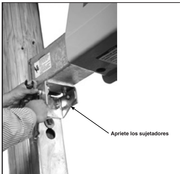
Figura 6. Instale y apriete los sujetadores.
