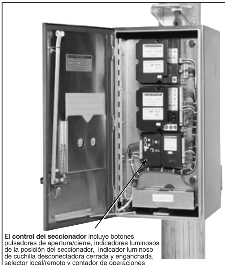
Figura 18. Operación del seccionador utilizando el selector local/remoto que está adentro de la CCU.
