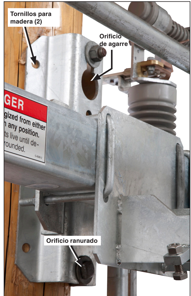
Figura 5. Detalle típico del enganche de la ménsula de montaje.
