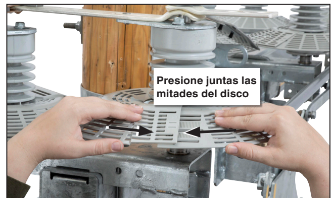
Figura 18. Presione juntas las mitades del disco. Presione la lengüeta superior en su lugar. Las mitades del disco deberían ajustarse tan apretadas contra el aislador como sea posible.
