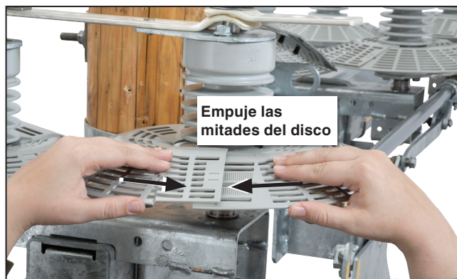
Figura 23. Empuje las mitades del disco una contra la otra. Presione la lengüeta superior en su lugar. Las mitades del disco deben quedar ajustadas contra el aislador tanto como sea posible.
