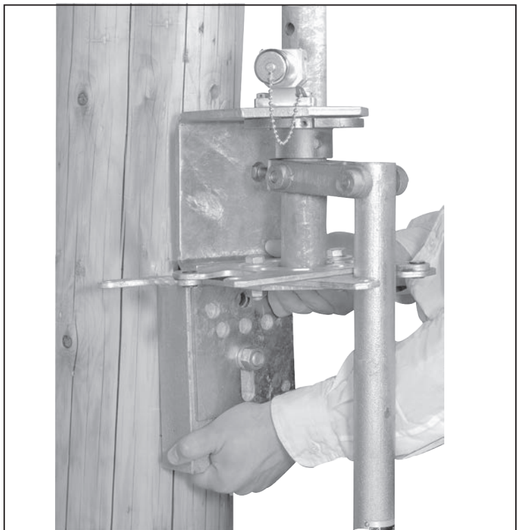
Figura 29. Posicione la ménsula de interbloqueo, el disco de bloqueo, el ensamble de la palanca de operación y el ensamble de la chumacera inferior en la sección más baja del tubo de operación vertical.
