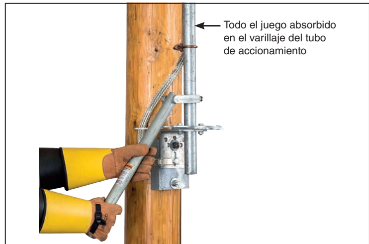
Figura 38. Verifique el enroscamiento.
