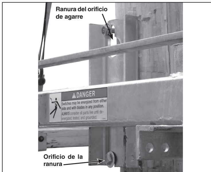
Figura 8. Pase las cabezas de los tornillos pasantes por el orificio de la ranura.
