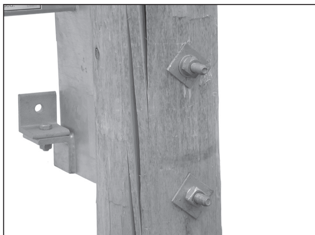
Figura 21. Fijación del interruptor con los tornillos.
