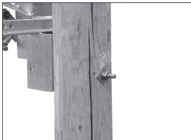
Figura 16. Fijación del interruptor con los tornillos.
