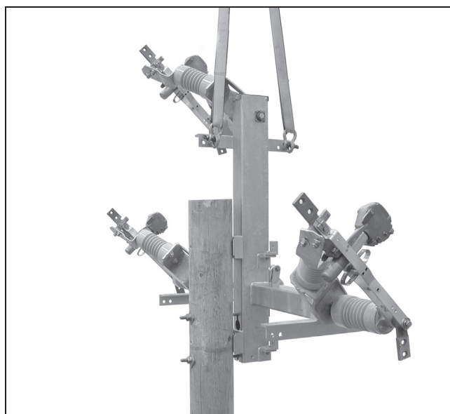
Figura 19. Elevación del interruptor hasta su posición.
