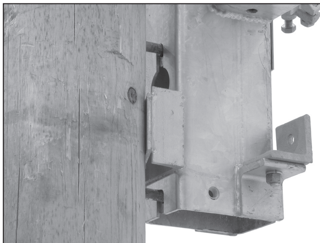
Figura 20. Guiar el Interruptor.
