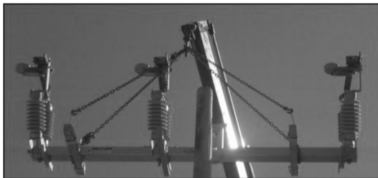
Figura 7. Colocación del interruptor.
