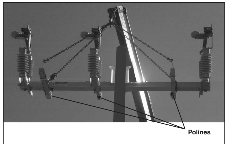
Figura 10. Retire los soportes de madera.
