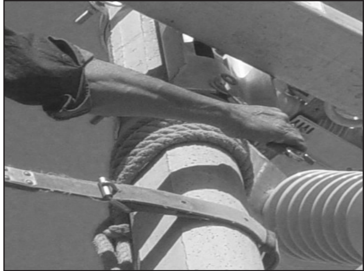
Figura 9. Sujeción del Interruptor a las abrazaderas.
