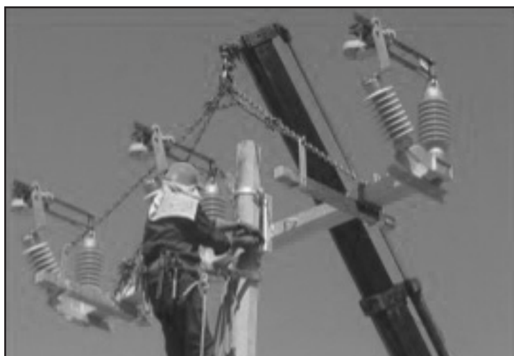
Figura 8. Sujeción de las abrazaderas del interruptor al poste.
