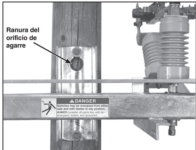
Figura 8. Guiando el interruptor.
