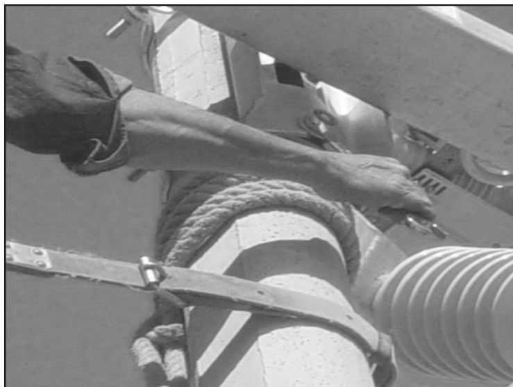
Figura 9. Sujeción del Interruptor a las abrazaderas.
