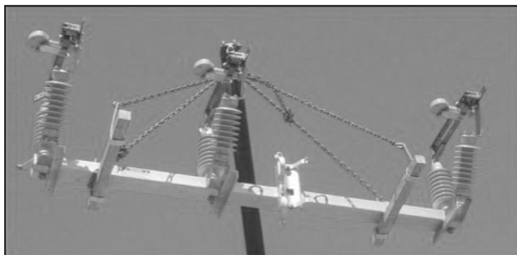
Figura 6. Elevación del interruptor a su posición.
