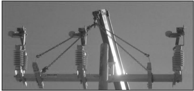
Figura 7. Colocación del interruptor.
