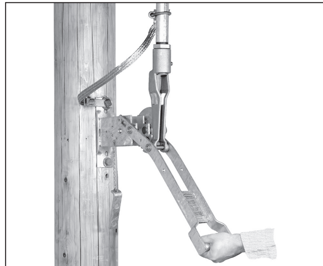
Figura 20. Verificando que la holgura haya sido recogida en la articulación de operación.
