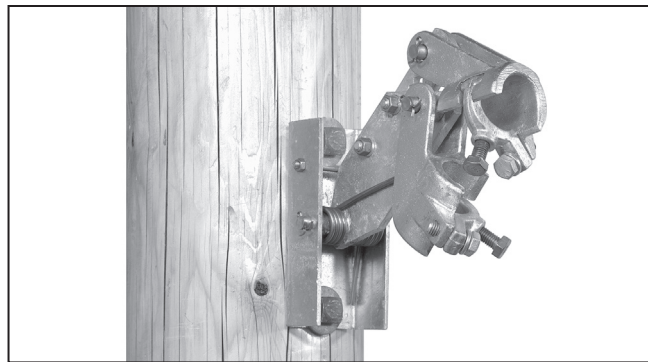
Figura 14. Añadiendo la guía de la varilla.
