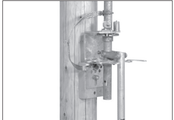
Figura 24. Liberación del perno de interbloqueo.
