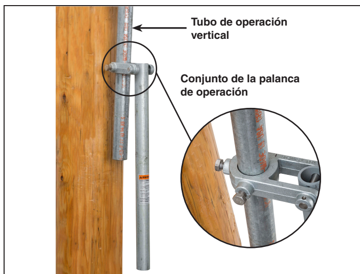
Figura 9. Instalación del conjunto de la palanca de operación.
