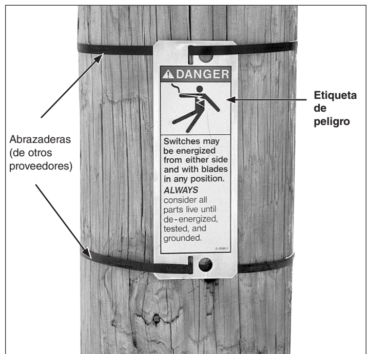
Figura 22. Colocación de la etiqueta de peligro en el poste o estructura.
