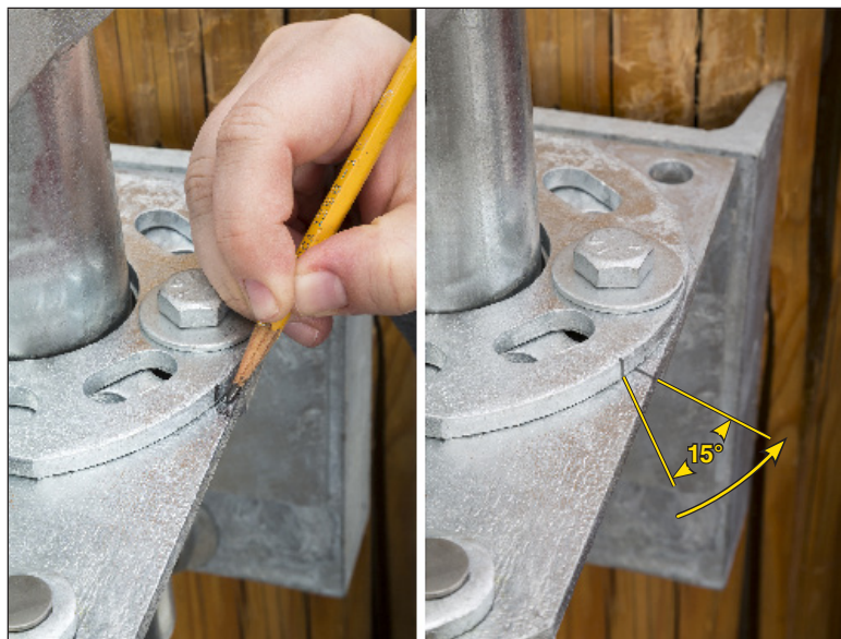
Figura 29. Marque la placa de tope y después afloje la tornillería y rote hacia atrás la placa de tope cerrada aproximadamente 15 grados.
