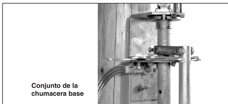
Figura 22. Instalación de la chumacera base.
