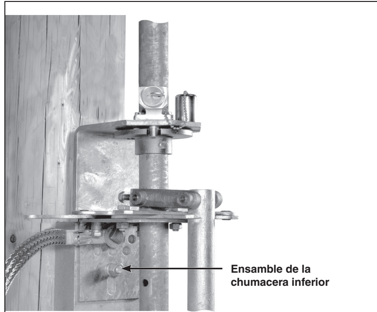
Figura 18. Sujeción del ensamble de la chumacera inferior.
