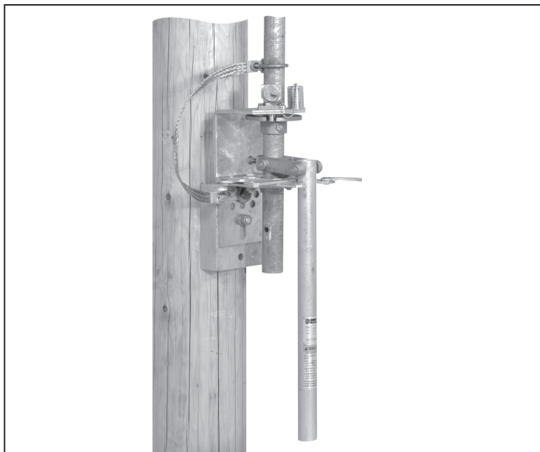
Figura 29. Desenganche del perno de la llave de interbloqueo.
