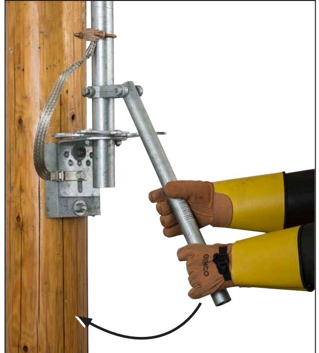
Figura 32. Mueva la palanca entre las placas de tope abiertas y cerradas. La palanca deberá ajustar firmemente en la placa cerrada.
