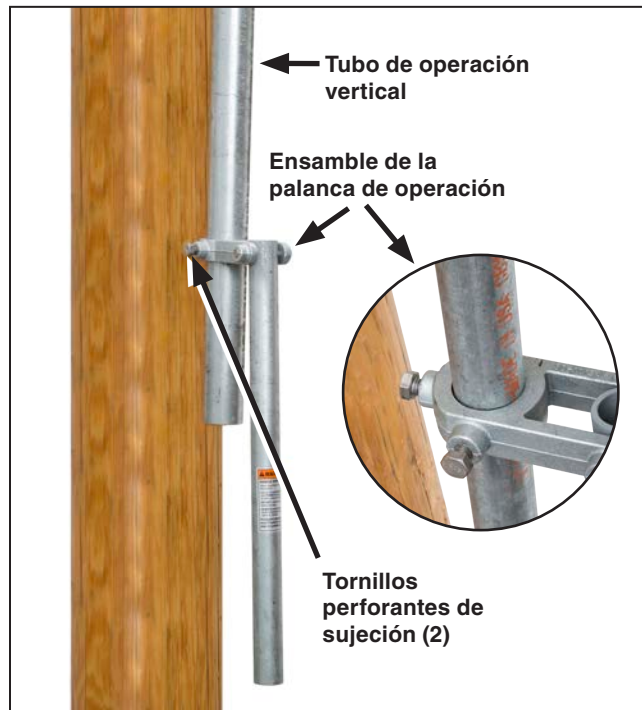
Figura 21. Instalación del ensamble de la palanca de operación.
