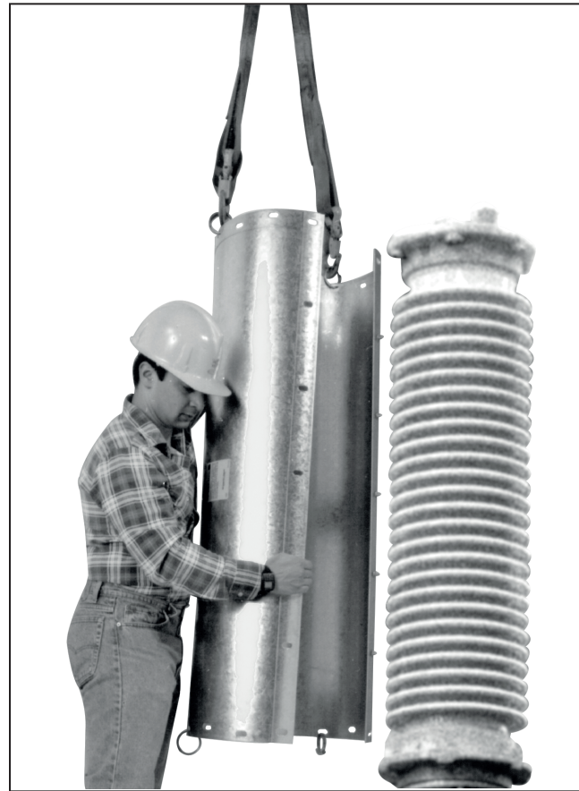
Figura 2. Elevación de un contenedor de cámara interruptiva de repuesto hasta su posición en una cámara interruptiva que se está reemplazando. Se ilustra el circuit-switcher Modelo 2030; el Modelo 2020 es similar.
