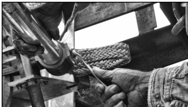
Figura 14C. Ensamblaje de la cuchilla de puesta a tierra.
