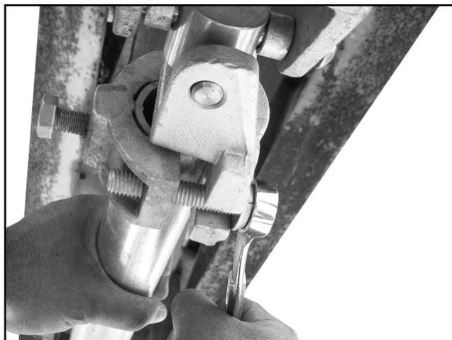
Figura 24. Instalación de la sección más alta del tubo de operación vertical.
