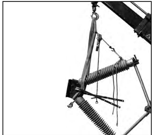
Figura 10A. Elevación de la cuchilla en vertical.
