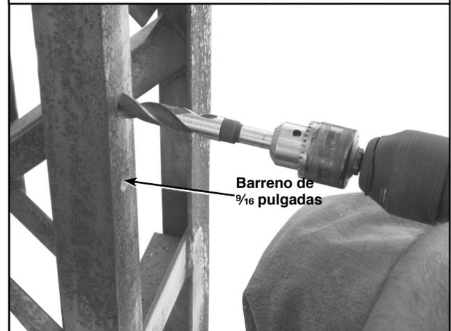
Figura 20A y 20B. Colocación y barrenado para sujetar ensamble de caja de baleros y demás piezas.
