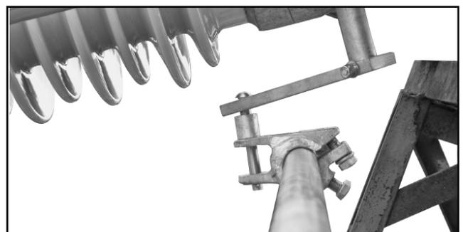
Figura 34B. Colocación de la palanca saliente de operación entre el espaciador y la cabeza del perno.
