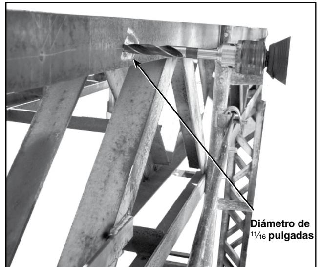
Figura 5. Barrenado de la estructura de montaje para la cuchilla.
