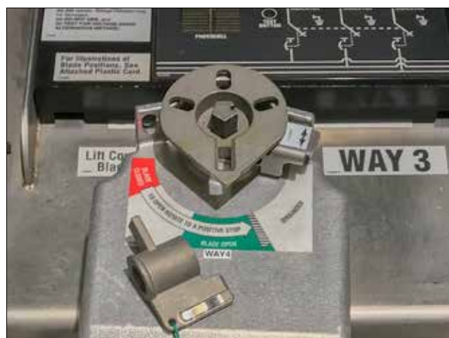
Figura 19. Moto operador recargado y en posición abierta.
