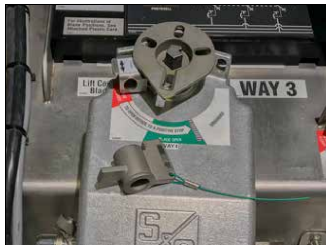
Figura 16. Selector de operación en la posición del extremo izquierdo.
