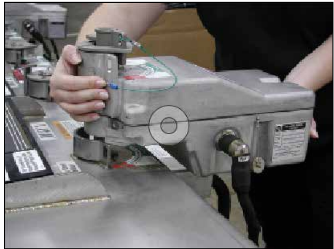
Figura 39. Levantar el moto operador.
