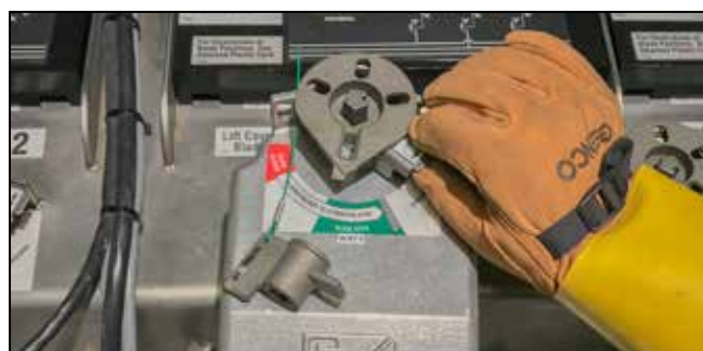
Figura 15. Girar el selector de operación para despejar el paso.
