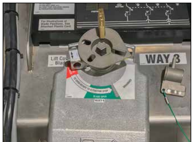
Figura 25. Posición de Aterrizado asegurada con llave de bloqueo.
