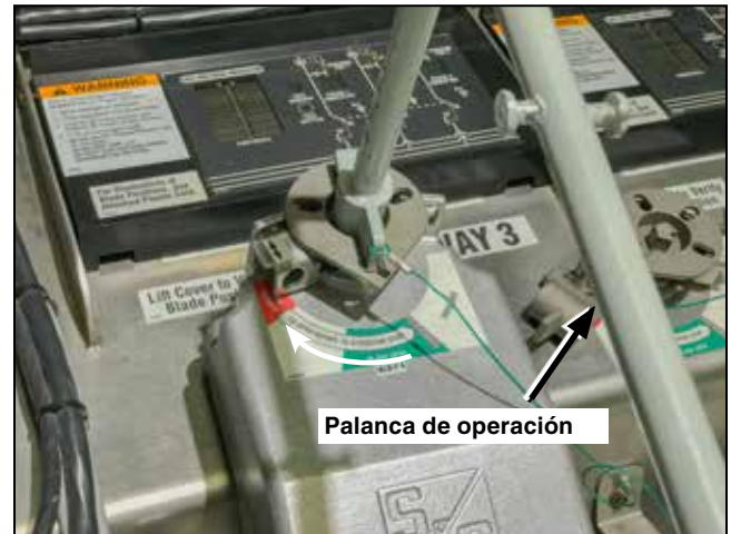
Figura 29. Retire la palanca de operación.
