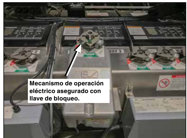
Figura 30. Reemplace el mecanismo de operación eléctrico asegurado con llave de bloqueo.
