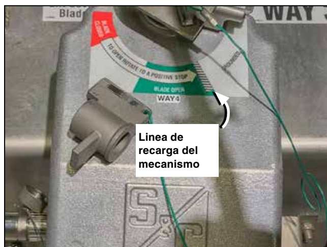
Figura 18. Girando la manija de operación manual.
