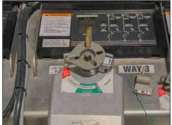
Figura 23. Posición de Cerrado asegurada con llave de bloqueo.
