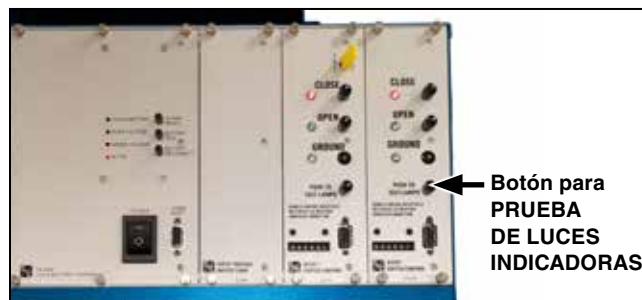
Figura 34. Botón para PRUEBA DE LUCES INDICADORAS.
