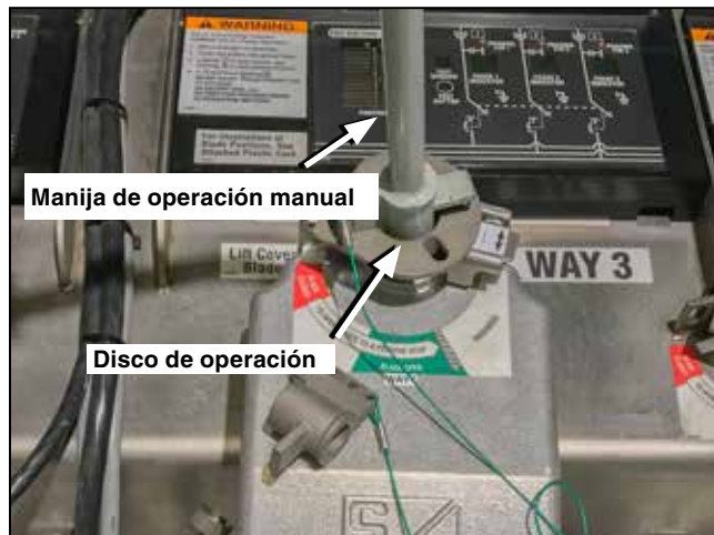
Figura 17. Introduciendo la manija de operación manual.
