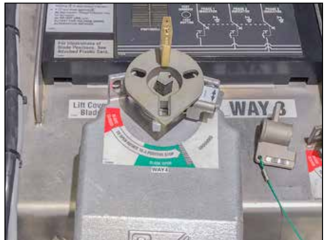
Figura 24. Posición de Abierto asegurada con llave de bloqueo.
