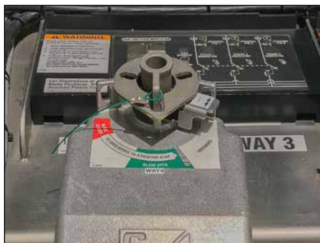
Figura 28. Indicación de posición Abierto.
