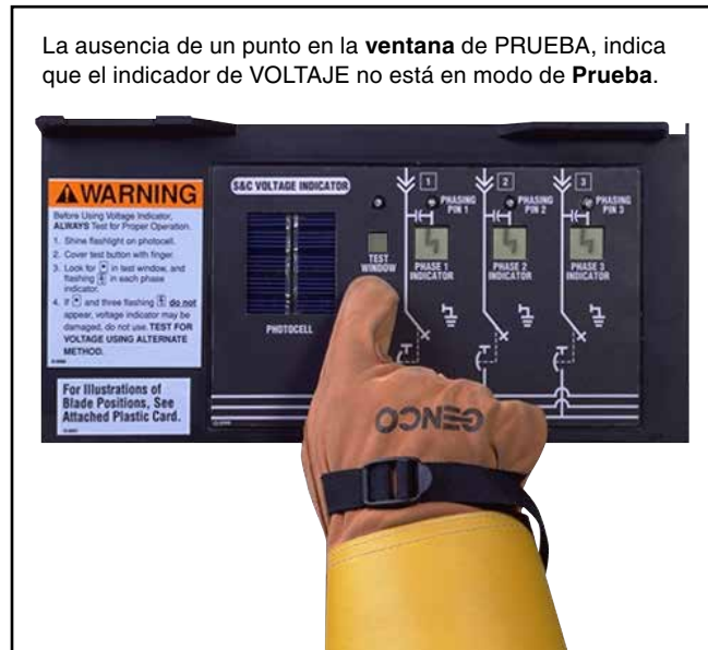
Figura 48. Asegurarse de que haya suficiente luz para activar el circuito de PRUEBA y que el botón de prueba esté totalmente cubierto por un dedo enguantado.
