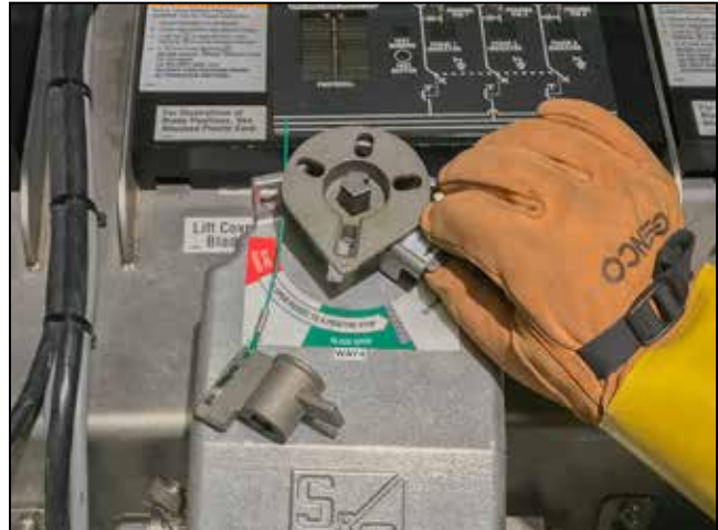
Figura 31. Gire el selector de operación para despejar el paso.
