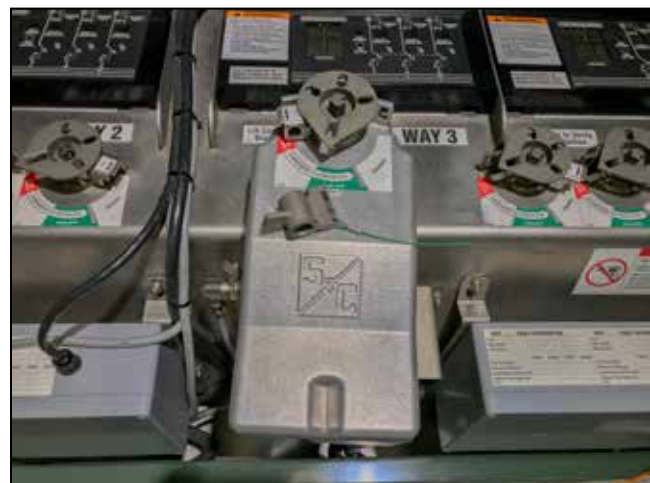
Figura 33. En la posición del extremo izquierdo, el selector de operación permite la operación entre Abierto y Aterrizado
