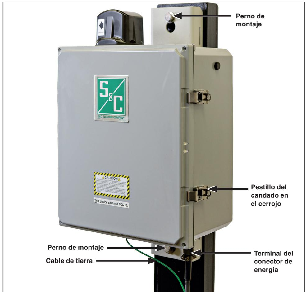
Figura 2. Montaje del gateway de comunicaciones al poste de la compañía eléctrica.
