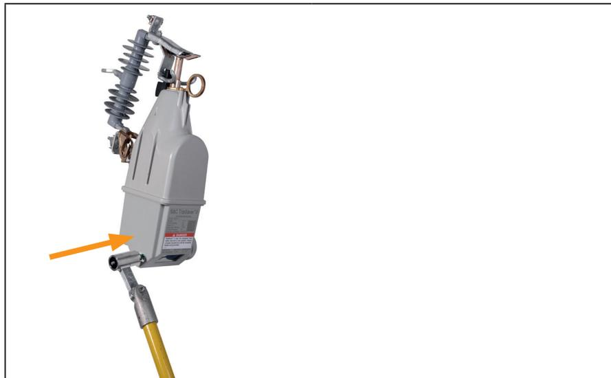
Figura 4. Mueva la herramienta magnética más cerca del reconectador.
