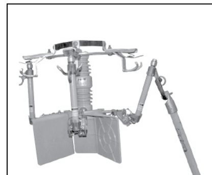
Figura 4c. Cierre del tercer portafusible.
