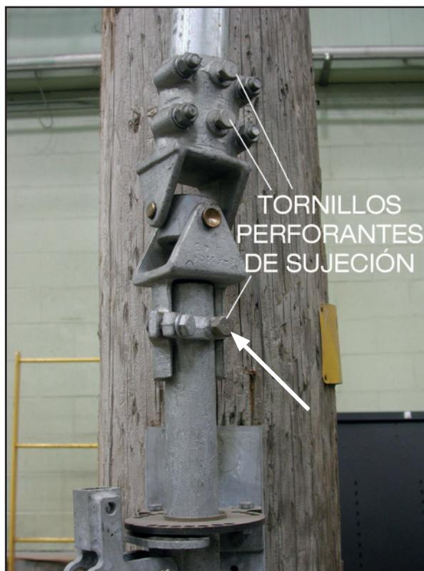
Figura 5. Ubicación de los tornillos perforantes de sujeción en la junta universal.
