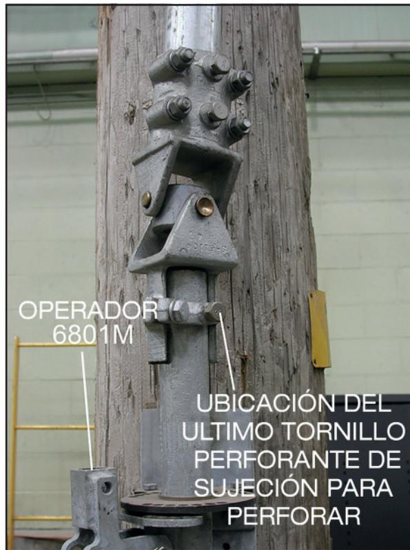
Figura 7. El tornillo perforante de sujeción para el eje de salida del operador de interruptores es el último en apretar.
