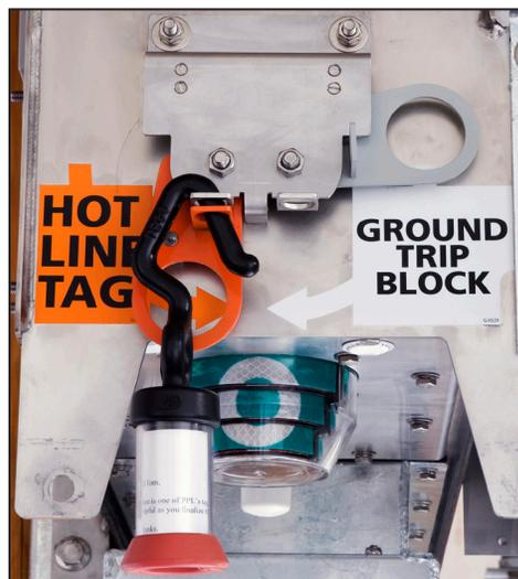
Figura 8. Modo Etiqueta de Linha Viva aplicado manualmente e “etiquetado”.
