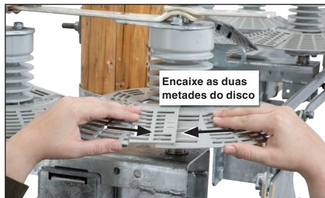
Figura 18. Comprima as duas metades do disco uma contra a outra. Encaixe a trava mais alta na posição. As metades do disco devem envolver o isolador da forma mais justa possível.
