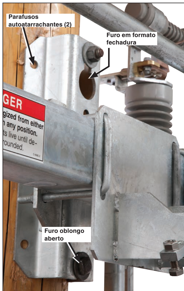
Figura 5. Detalhe de uma fixação típica do suporte.
