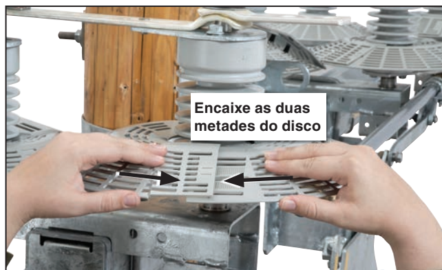
Figura 23. Comprima as duas metades do disco uma contra a outra. Encaixe a trava superior na posição. As metades do disco devem abraçar o isolador da melhor forma possível.
