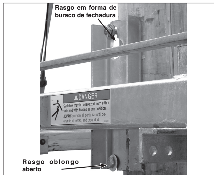
Figura 8. Faça o encaixe entre os parafusos passantes e os rasgos.
