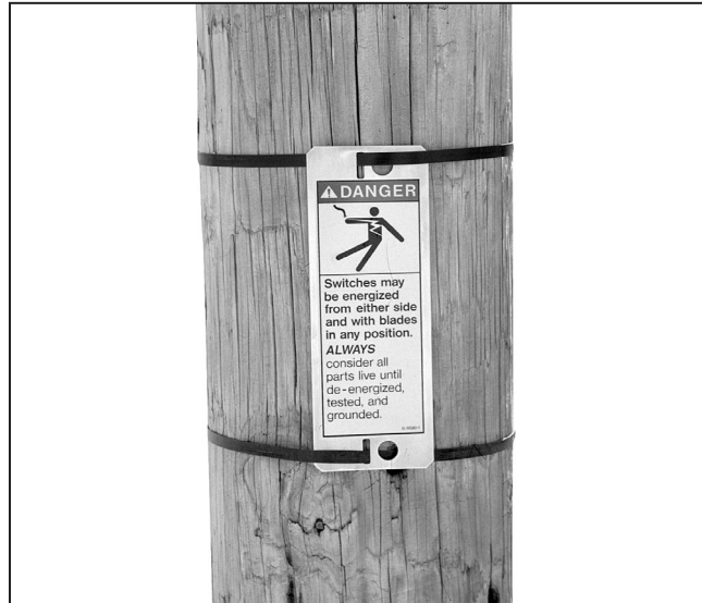
Figura 42. Fixação da etiqueta de perigo ao poste ou à estrutura.
