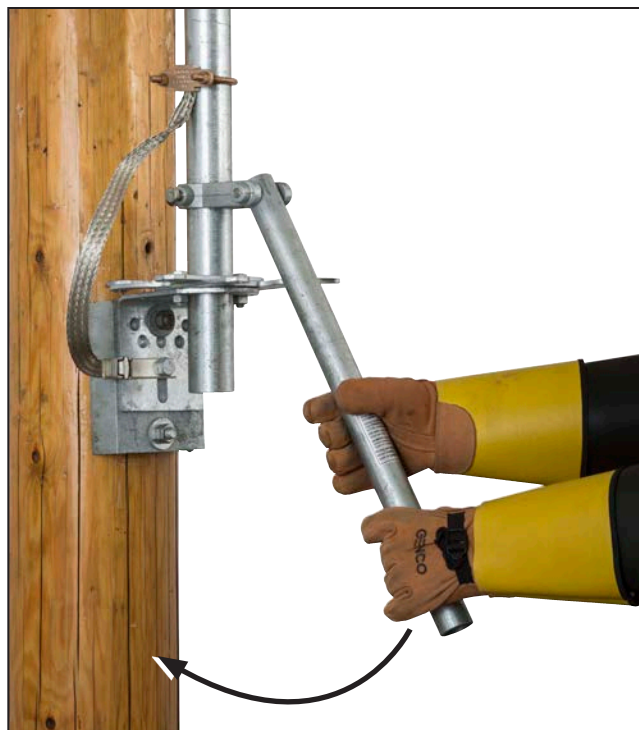
Figura 32. Movimento a alavanca entre as placas de parada de abertura e fechamento. A alavanca deve encaixar de forma justa na placa de parada.
