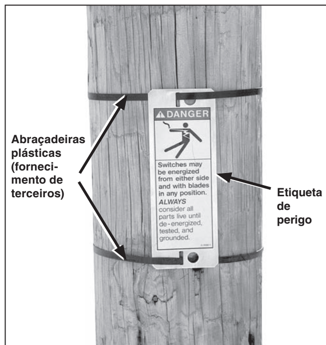
Figura 42. Fixação da etiqueta de perigo ao poste ou à estrutura.
