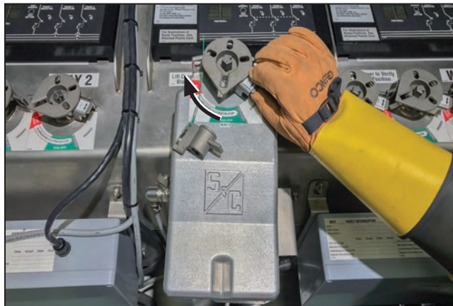
Figura 31. Gire o seletor de operação para fora da posição.
