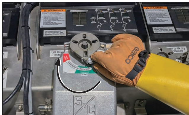
Figura 20. A movimentação do seletor de operação totalmente para a esquerda habilita a operação para a posição Aterrada.
