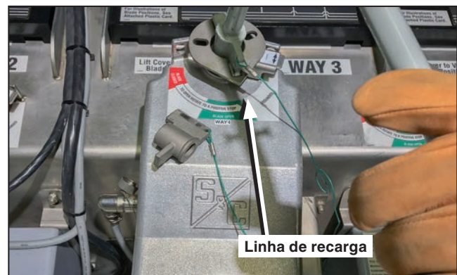
Figura 18. Gire a alavanca de operação manual.
