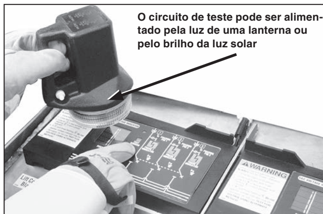
Figura 43. Coloque um dedo (usando luvas) sobre o botão de TESTE para iniciar o teste.
