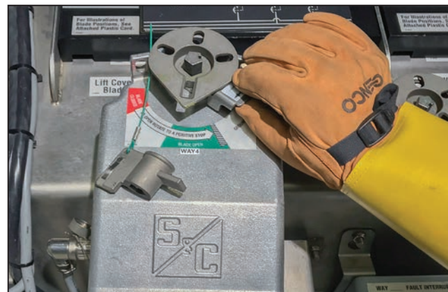
Figura 15. Movimente o seletor de operação para fora de sua posição.
