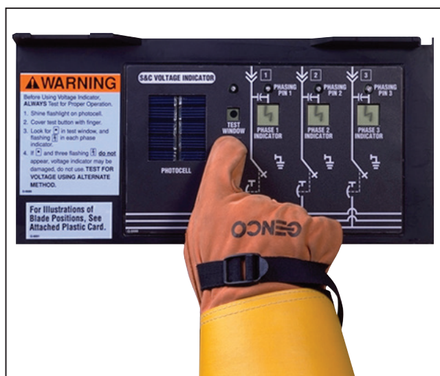
Figura 44. O indicador de TENSÃO está funcionando corretamente se aparecer um ponto na janela de TESTE e um símbolo de raio piscando aparecer em cada indicador de FASE.
