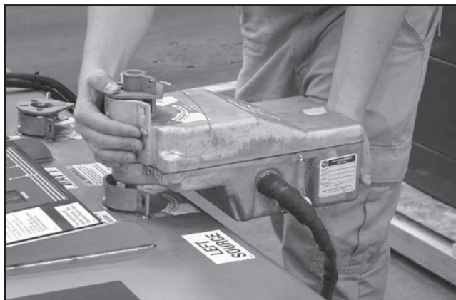
Figura 36. Levante o operador motorizado.
