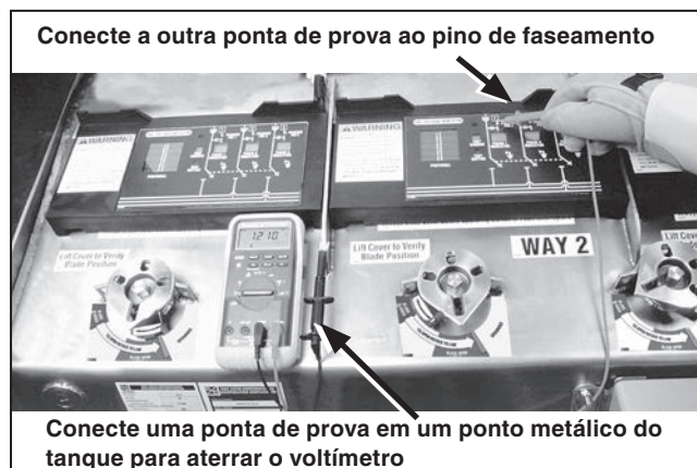
Figura 49. Uma ponta de prova é conectada a um ponto metálico do tanque e a outra ponta de prova a um pino de faseamento.
