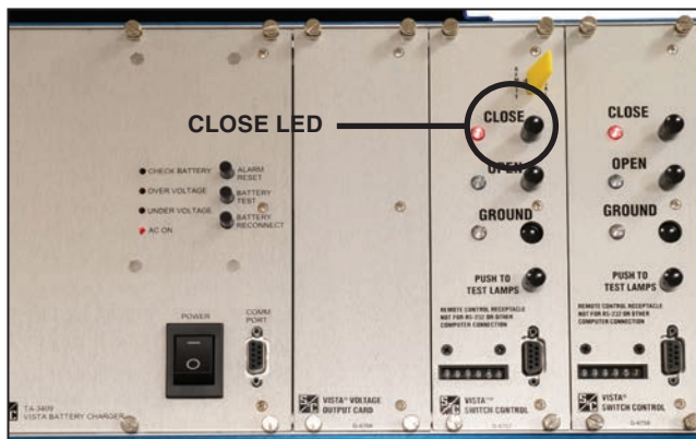
Figura 28. Indicador da posição Fechada na placa de controle do motor consistente com a posição do operador motorizado.
