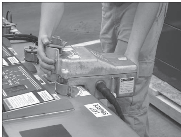
Figura 38. Reposicione o operador motorizado.
