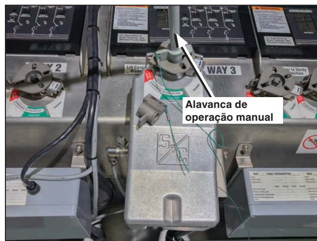
Figura 29. Remoção da alavanca de operação.
