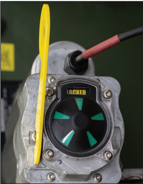
Figura 3. Interruptor para bucha tipo poço na posição Aberta e Travada.
