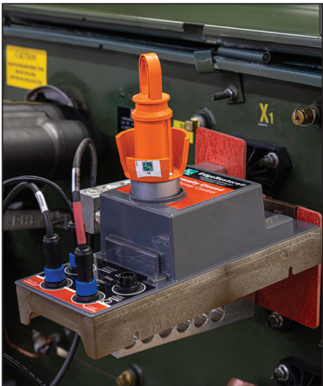
Figura 6. Módulo de alimentação conectado ao controle do sistema EdgeRestore.
