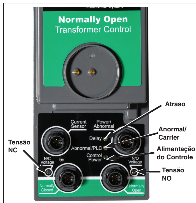
Figura 23. Indicadores LED em um controle normalmente aberto.
