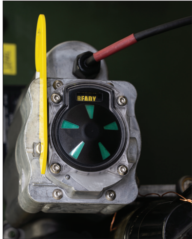
Figura 20. Interruptor para bucha tipo poço na posição Aberta e Pronta . Nesta posição, a operação automática está habilitada.
