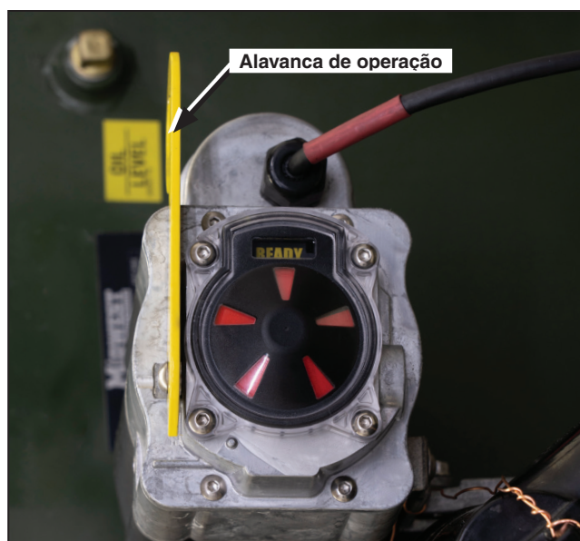
Figura 15. Interruptor para bucha tipo poço na posição Fechada e Pronta.
