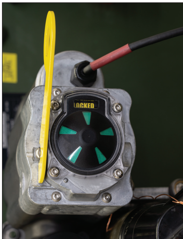
Figura 12. Interruptor para bucha tipo poço na posição Aberta e Travada.
