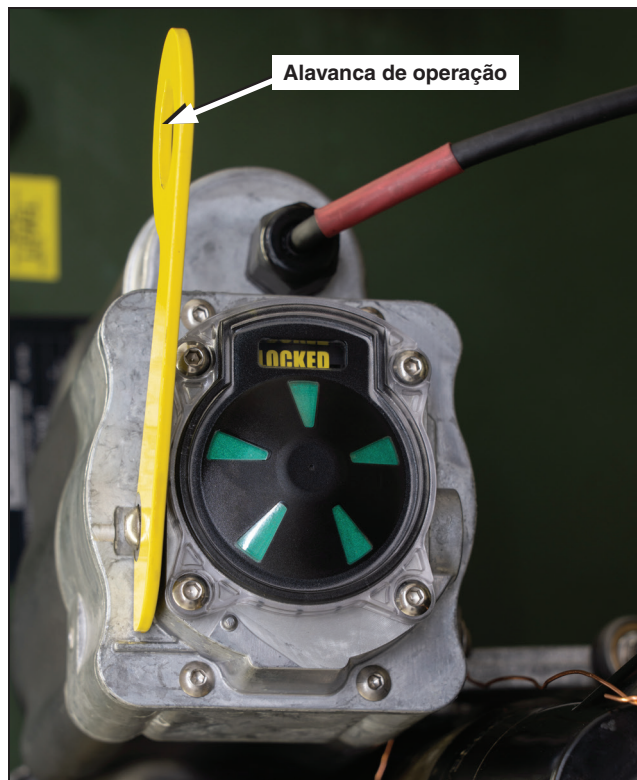
Figura 13. Bascule a alavanca de operação amarela em direção ao transformador seguido da direção oposta por três vezes, parando na posição Pronta (retorno).
