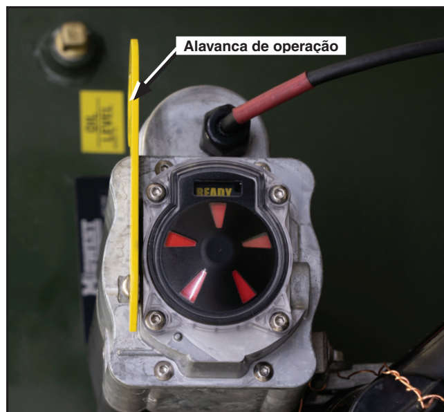
Figura 11. Movimente a alavanca de operação amarela para a direção oposta ao transformador.
