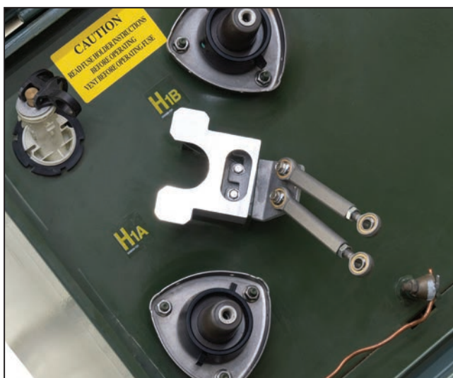
Figura 16. Instalação completa do suporte de apoio com extensor.
