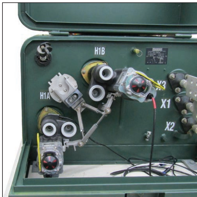
Figura 31. Instalação concluída do espaçador da ponte de espera.
