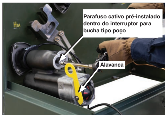
Figura 18. Alinhe o interruptor para bucha tipo poço com o inserto. Aperte o parafuso cativo com o torque recomendado.
