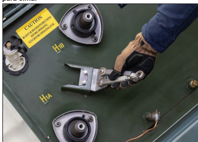
Figura 12. Abaixar até que os parafusos toquem na borda da abertura da ponte de espera.
