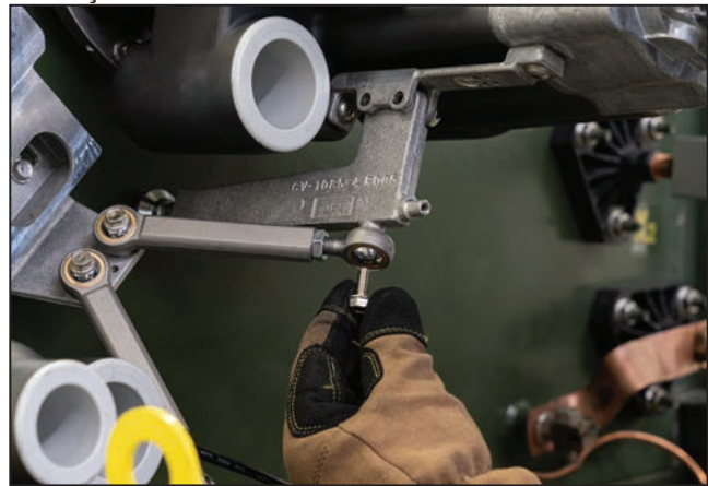
Figura 21. Instalação do parafuso de conexão do extensor ajustável ao suporte do pé giratório.
