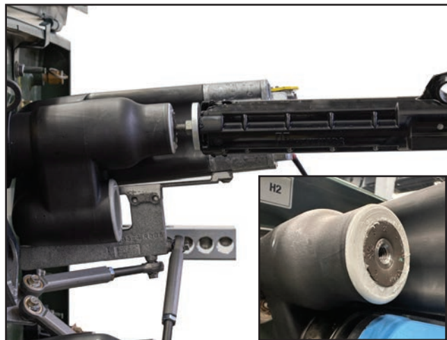
Figura 34. Empurre para dentro do interruptor para bucha tipo poço e rosqueie na abertura.
