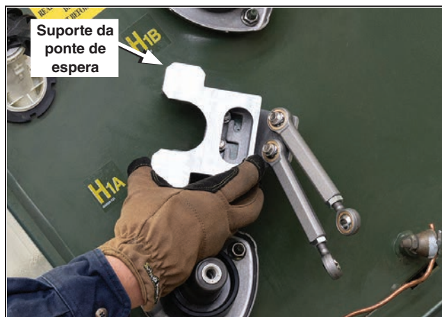
Figura 13. Deslize o suporte da ponte de espera na direção dos dois parafusos.
