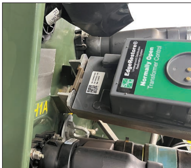
Figura 44. Colocação do controle na ponte de espera.
