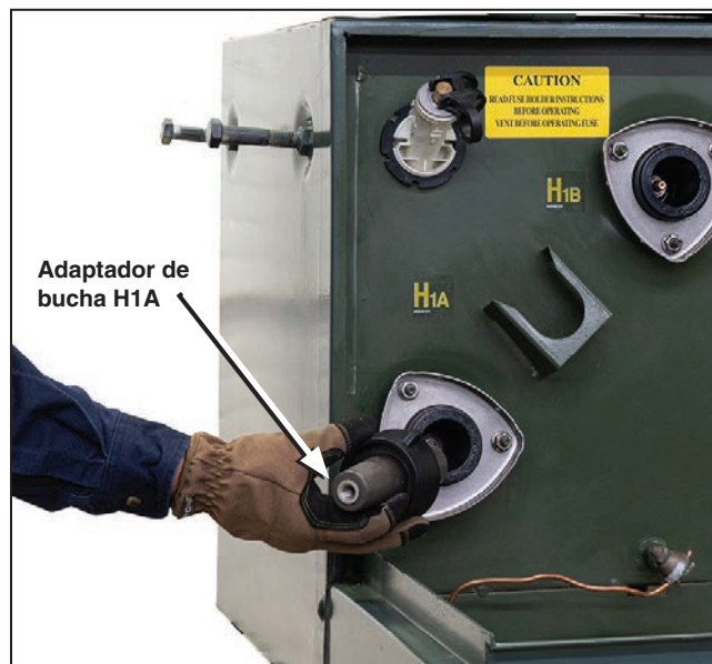
Figura 6. Antes de instalar o adaptador de bucha, lubrifique a parte cônica a ser inserida.
