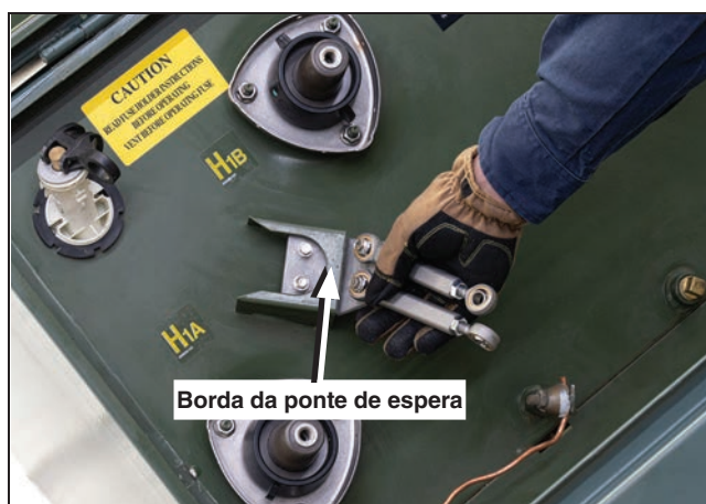
Figura 11. Movimento o suporte de apoio com extensor para cima.
