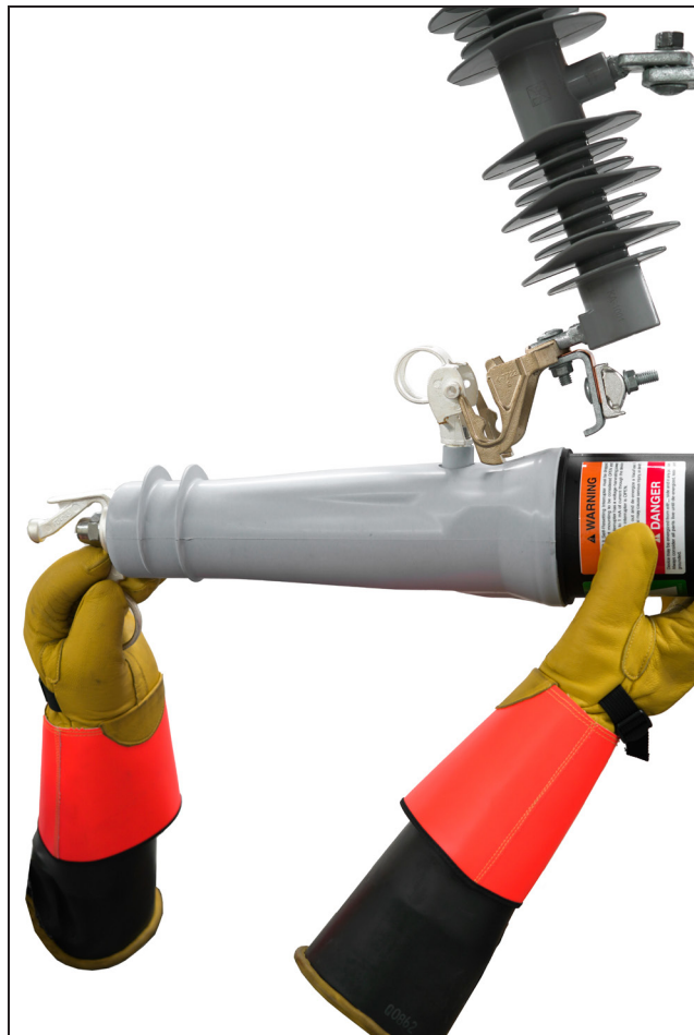
Figura 14. Remoção do interruptor VacuFuse II com as mãos enluvadas.
