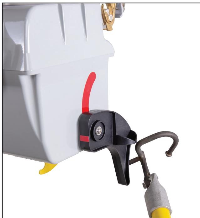
Figura 19. O modo NR é obtido movimentando a alavanca de SELEÇÃO DE MODO para baixo.
