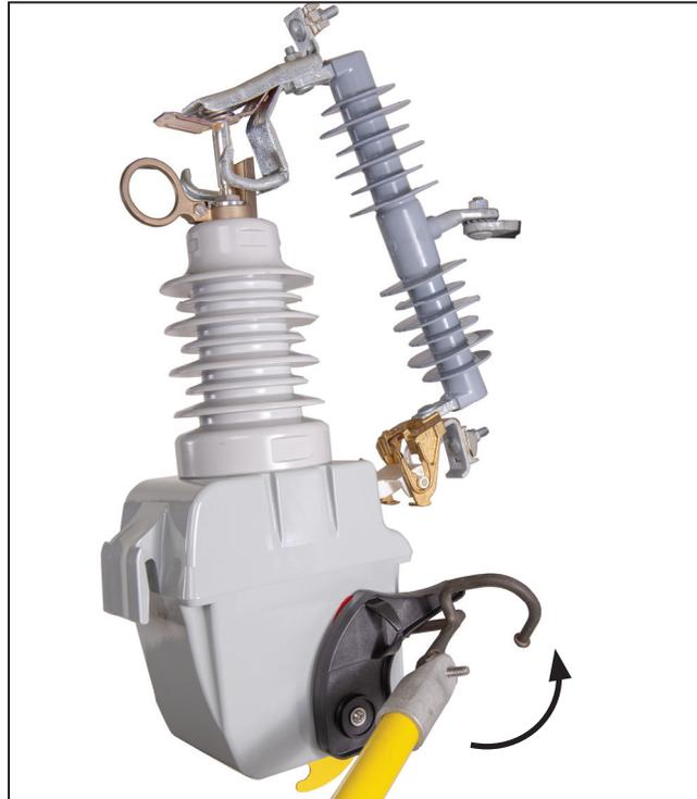
Figura 20. O modo Auto é obtido movimentando a alavanca de SELEÇÃO DE MODO para cima.
