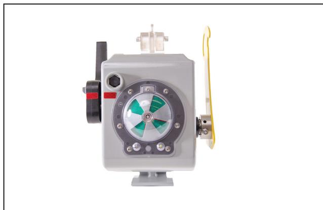
Figura 9. Interruptor com Rearme Automático VacuFuse na posição Aberta.
