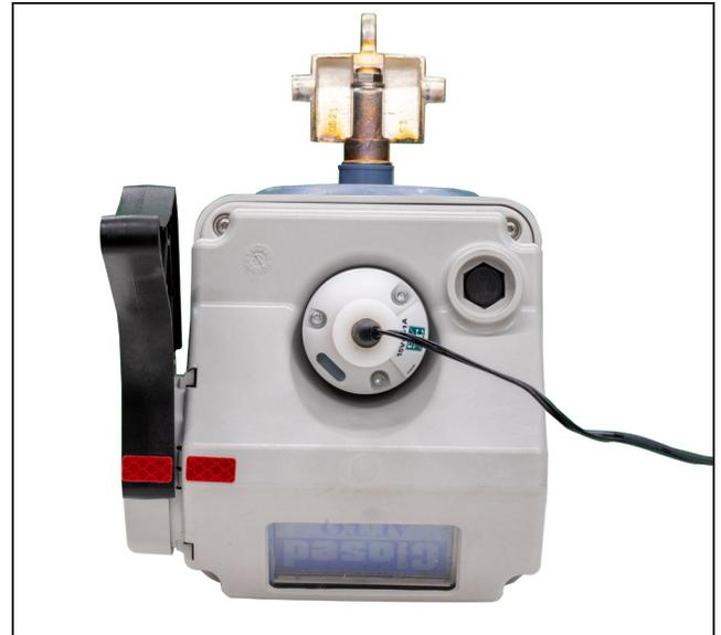
Figura 2. Módulo de alimentação conectado à base do religador TripSaver II.
