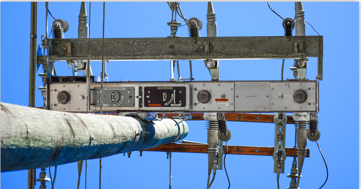
FIGURE 1. Os interruptores de falta IntelliRupter ajudaram a Ameren Missouri no aumento da segmentação dos alimentadores.
