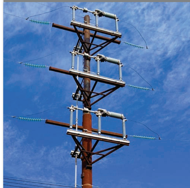
Figura 2. Vista lateral da instalação do Circuit-Switcher Mark V.
