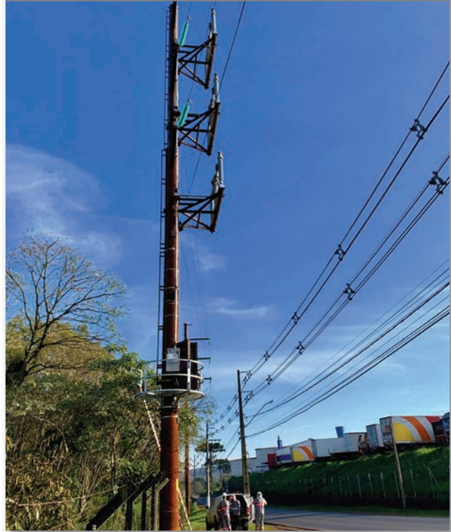
Figura 2. Vista lateral da instalação do Circuit-Switcher Mark V.
