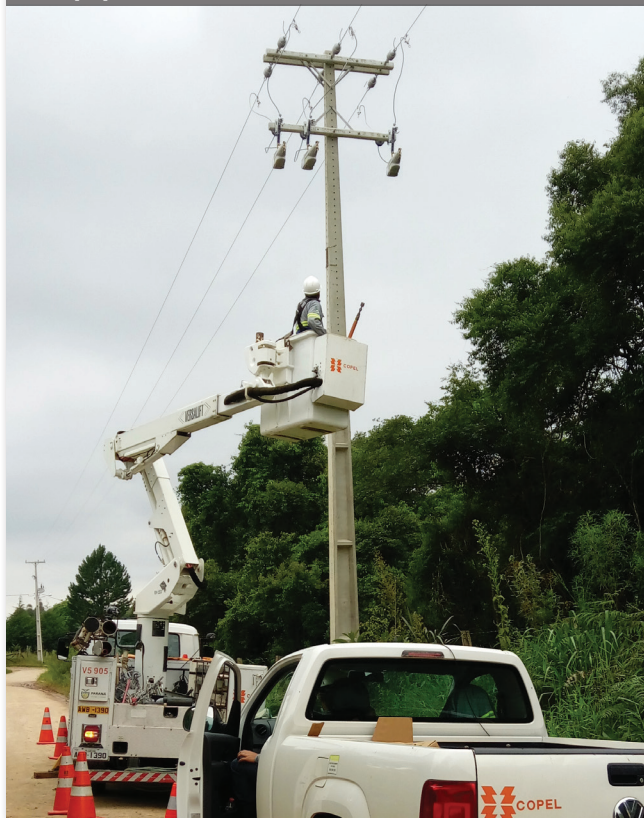
Instalação dos religadores TripSaver II por equipe da COPEL.
