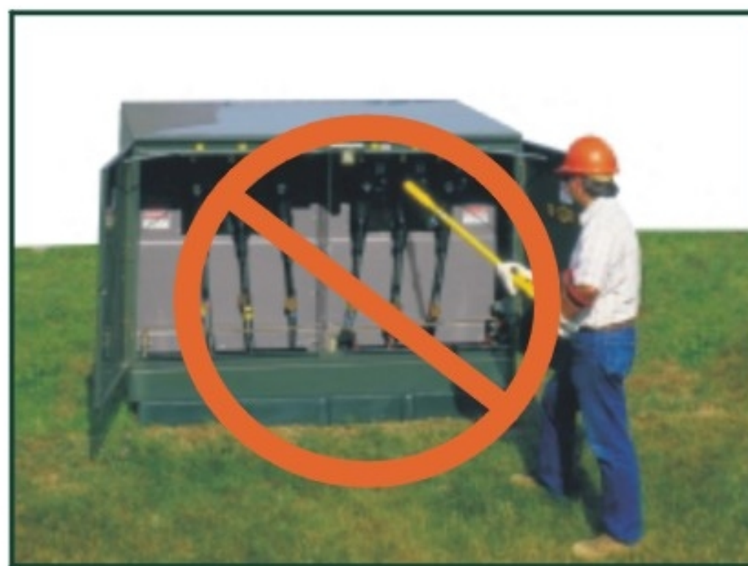
与常规肘形连接的开关柜不同，操作人员无需操作中压电缆
