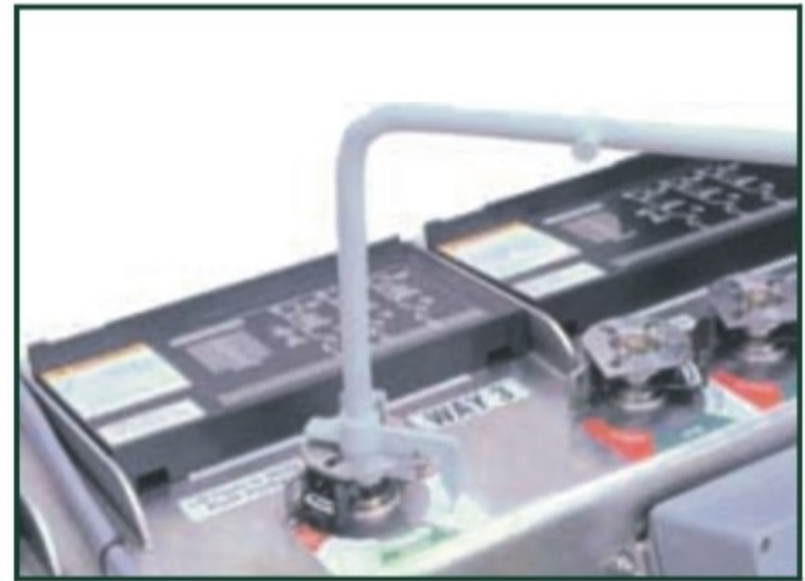
将负荷开关（或断路器）打至接地位置
