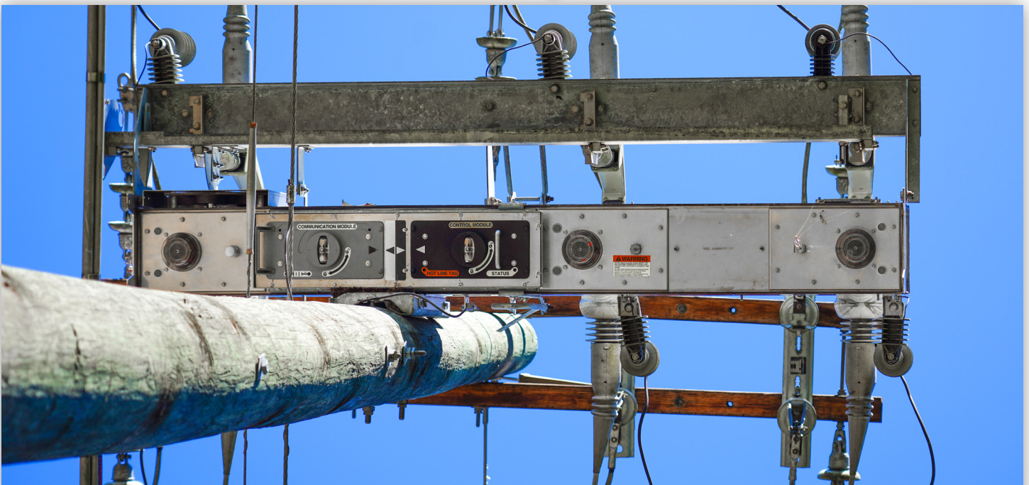
FIGURA 1. Los interruptores de fallas IntelliRupter ayudaron a Ameren Missouri a aumentar la segmentación de sus alimentadores.
