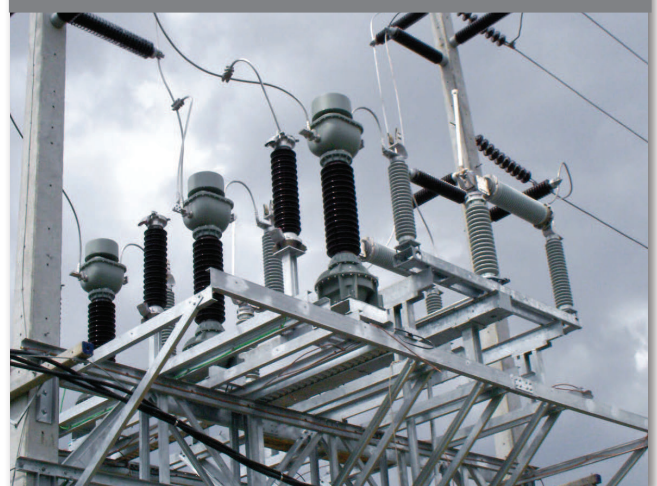
Figura 2. Serie 2000 con sensores de tensión y corriente.
